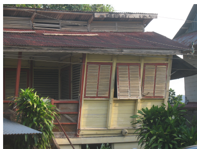
Détail de l'étage à l'est. Etat avant restauration IVR03_202697300038NUCA
