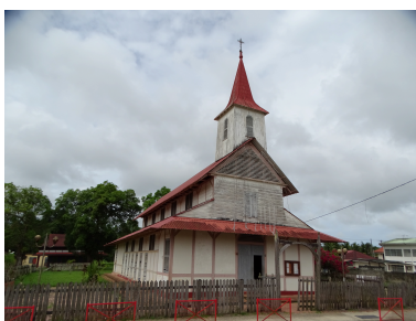
Vue générale Phot. Lionel Besnard IVR03_202697300003NUCA
