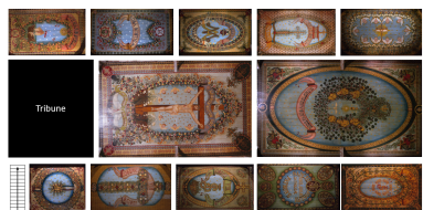
Disposition des différents éléments du décor dans le plafond Phot. Lionel Besnard IVR03_202697300012NUCA
