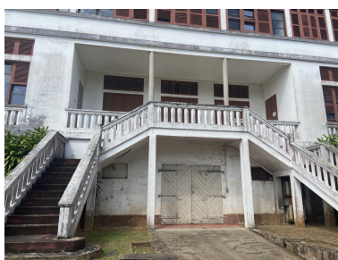
Façade est de l'hôtel du secrétaire de préfecture, oeuvre de l'architecte Boris Ziwès, 1952 Phot. Lionel Besnard IVR03_202697300024NUCA
