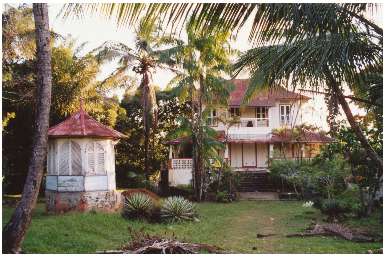
La façade nord et la fabrique de jardin gauche, état en 2002.
