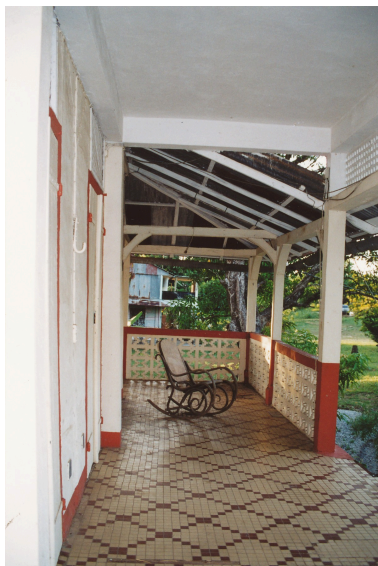
La galerie, vue intérieure, état en 2002. Phot. Marie-Pascale Malle IVR03_200297300475ZE
