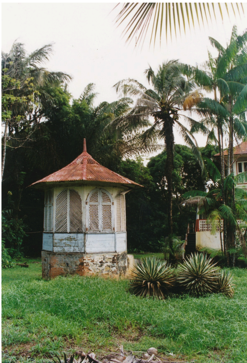
La fabrique de jardin gauche, état en 2002
