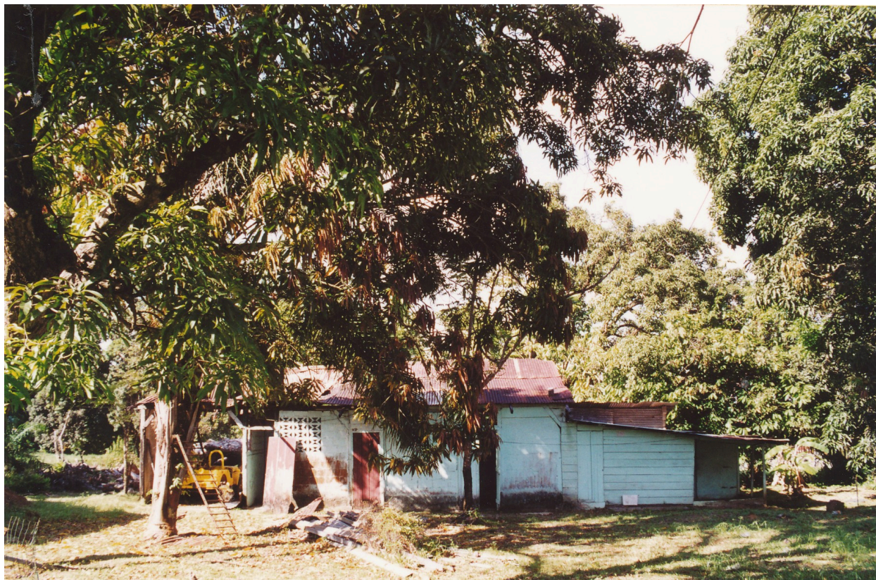
L'une des servitudes: façade nord, état en 2002
