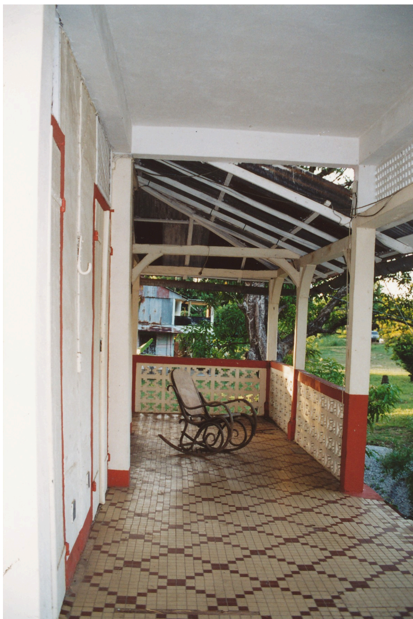
La galerie, vue intérieure, état en 2002.
