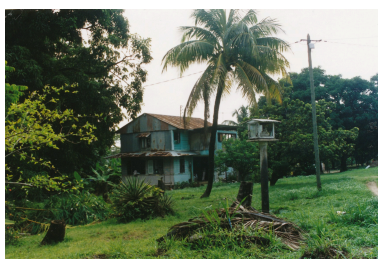
La maison des employés, avec au premier plan, la "chapelle", état en 2002 Phot. Marie-Pascale Mallé IVR03_200297301029ZE
