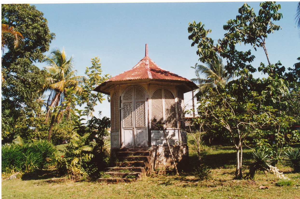
La fabrique de jardin droite, vue du sud-est, état en 2002
