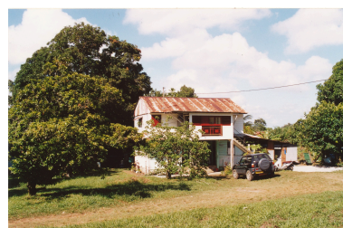
La maison des employés : façade nord, état en 2002 Phot. Marie-Pascale Mallé IVR03_200297300490ZE
