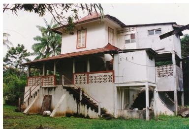
La façade ouest, état en 2002 Phot. Marie-Pascale Malle IVR03_200297301031ZE
