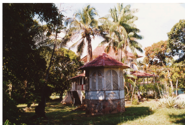
La façade ouest et la fabrique de jardin droite Phot. Marie-Pascale Mallé IVR03_202697300482ZE
