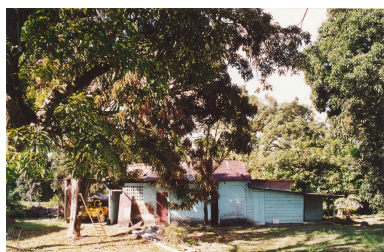
L'une des servitudes: façade nord, état en 2002 Phot. Marie-Pascale Mallé IVR03_200297300488ZE
