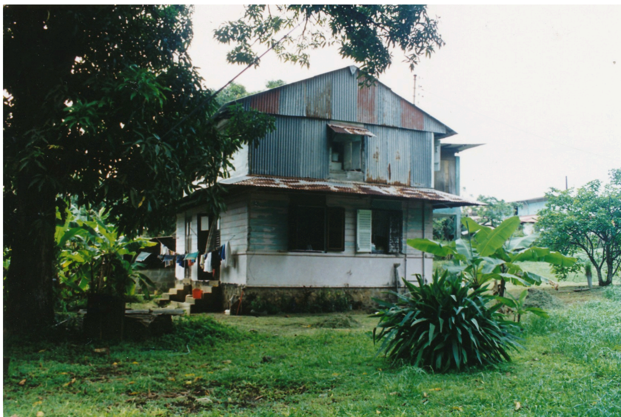
Le logement des employés, façade est, état en 2002
