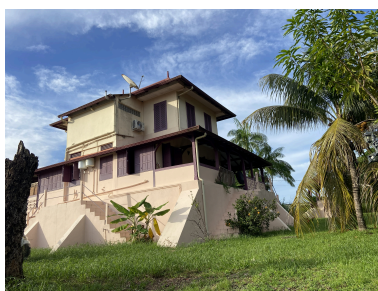
La maison depuis l'angle sud-est de la parcelle, état en mai 2026 Phot. Lionel Besnard IVR03_202697300162NUCA
