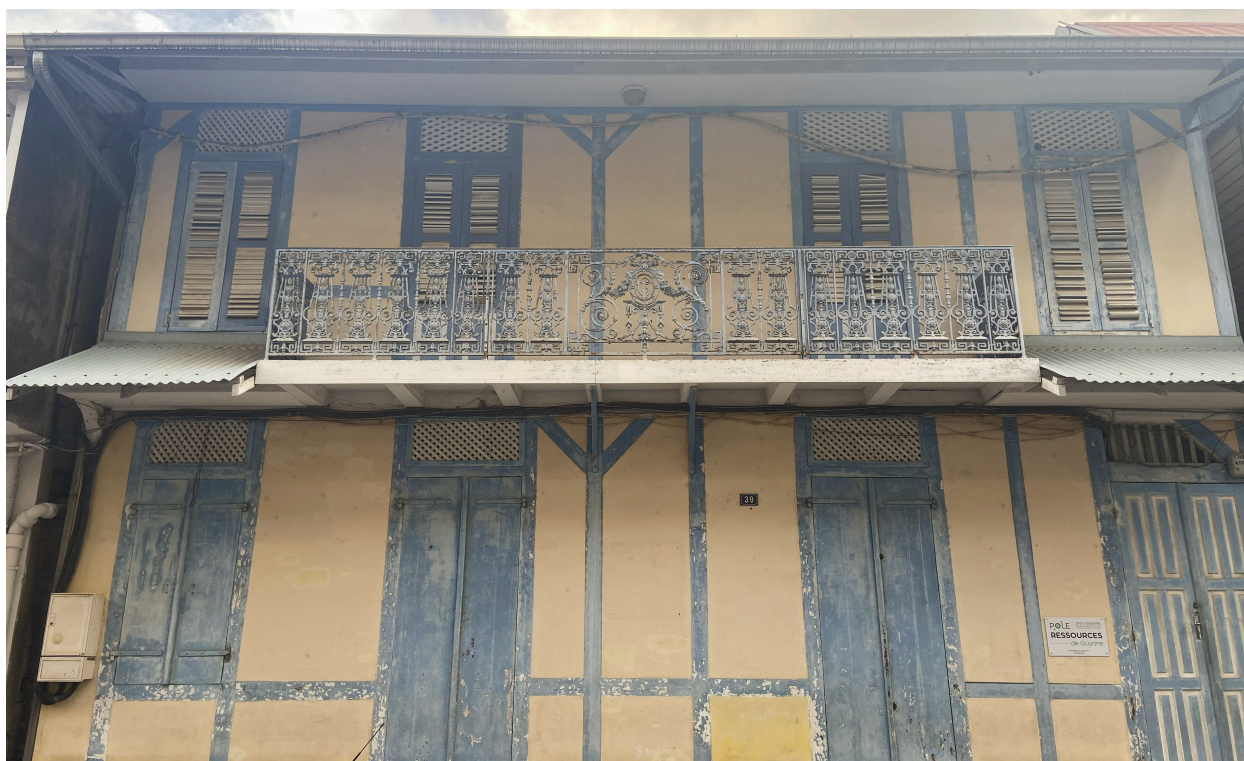
Façade sud, vue générale, état en 2026
