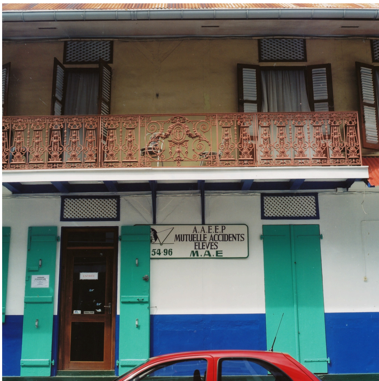
Façade sud, le balcon en ferronnerie en 2000.
