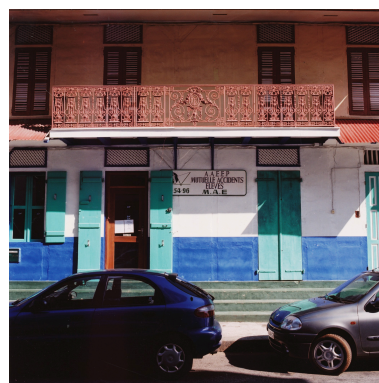
La faade sud, trav es centrales en 2001. Phot. Marc Heller IVR03_200197303421XE
