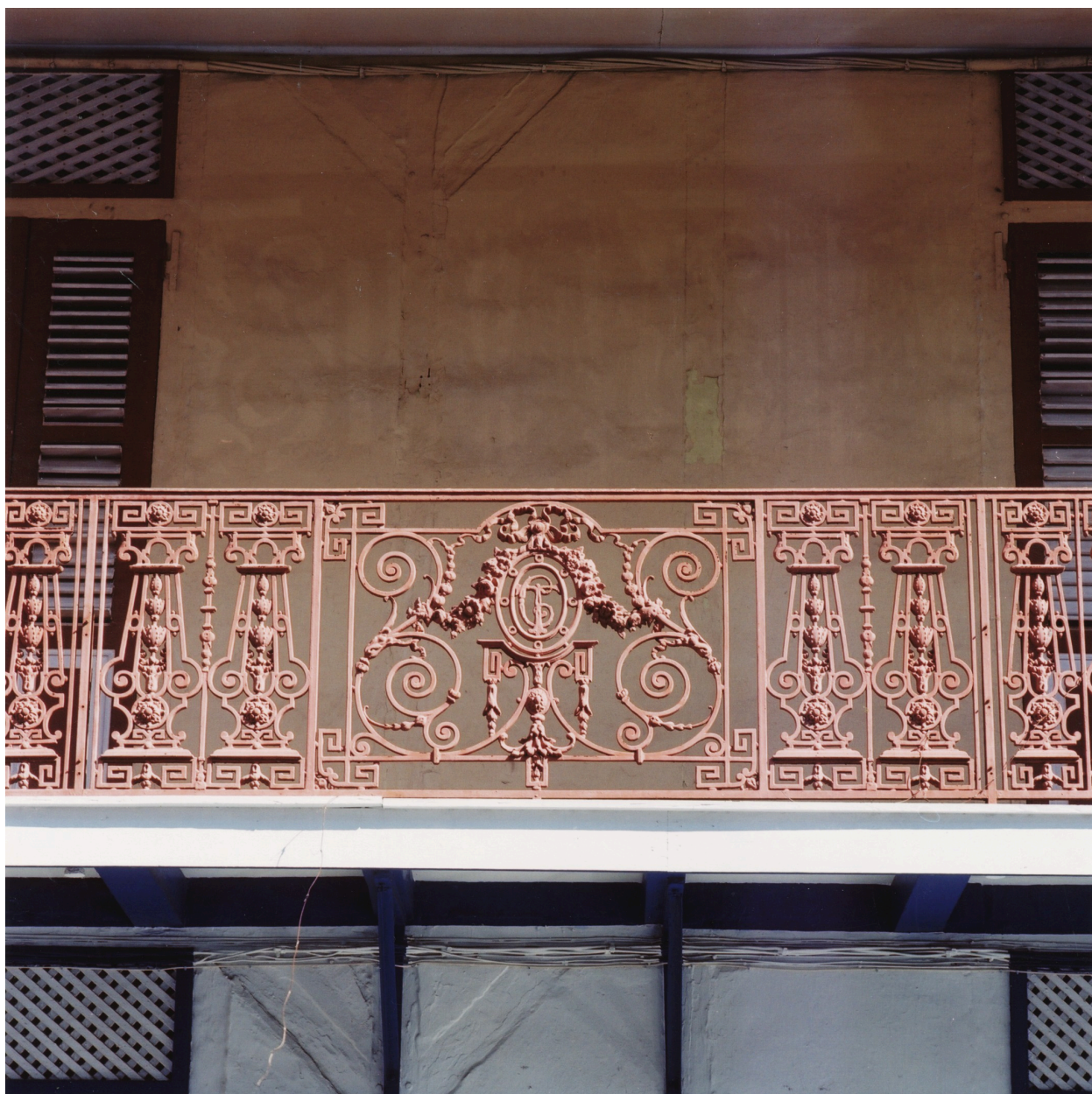
Le balcon de l'étage, détail du garde-corps en 2001.
