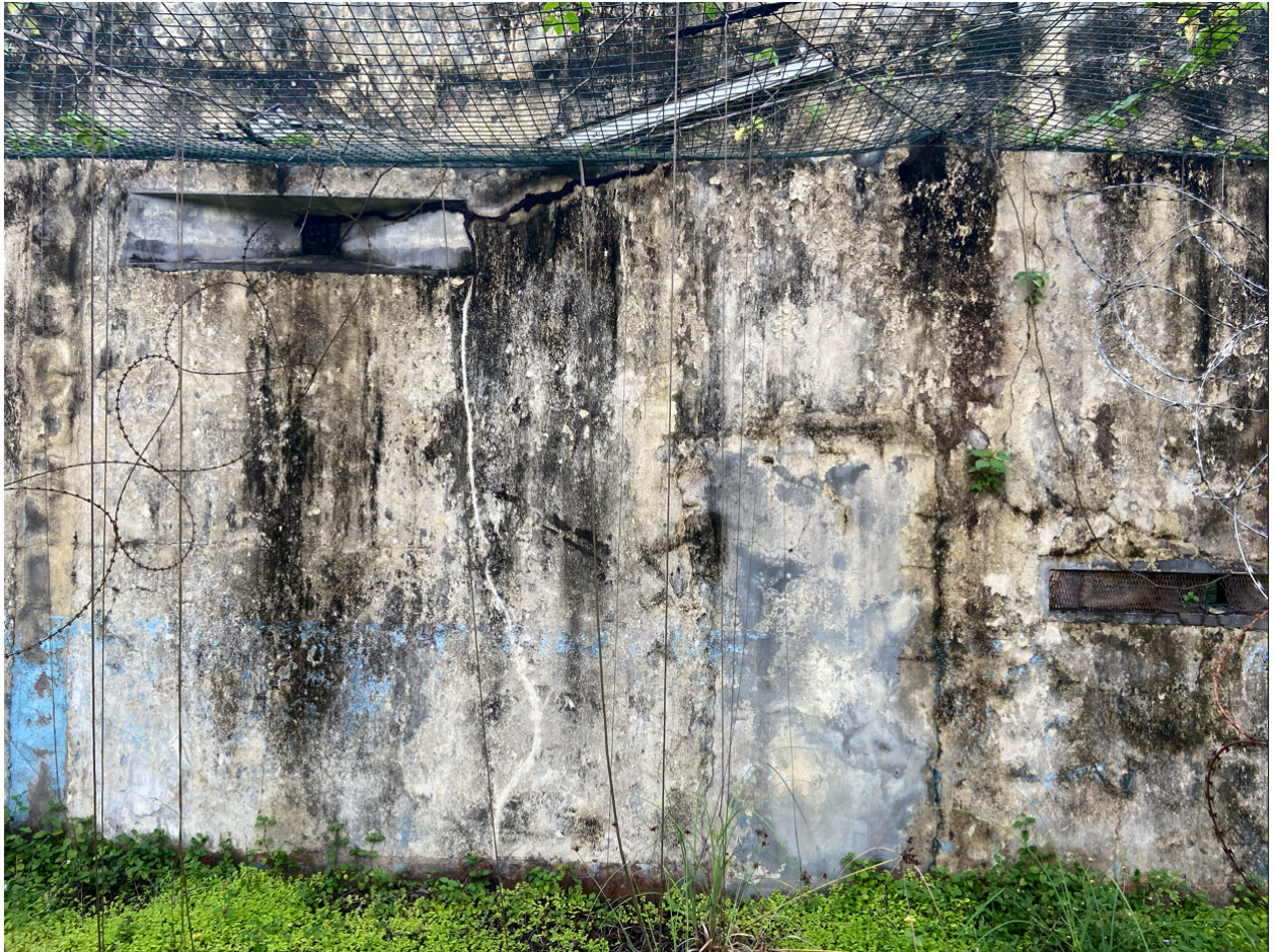
Détail de deux bouches à feu depuis la cour des prévenus vers l'est, état en mai 2026.
