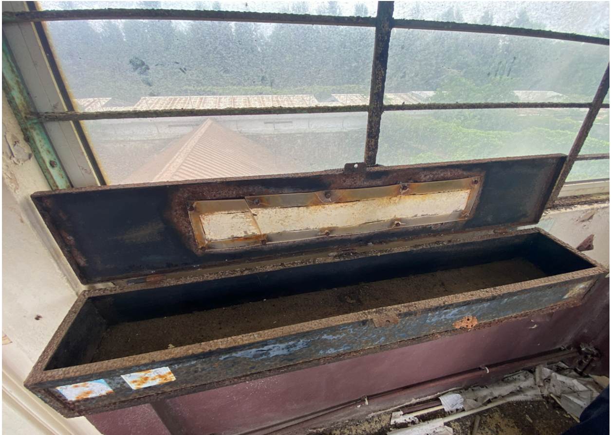
Belvédère, détail d'un porte-fusil (?), état en mai 2026.
