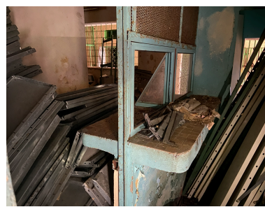
Parloir des familles au rez-de-chaussée du pavillon principal, depuis l'accès détenus, état en mai 2026 Phot. Lionel Besnard IVR03_202697300069NUCA
