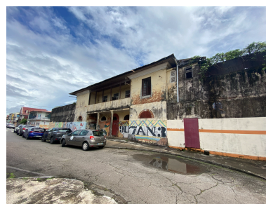
Vue générale de la façade ouest, rue Arago, état en mai 2026 Phot. Lionel Besnard IVR03_202697300063NUCA
