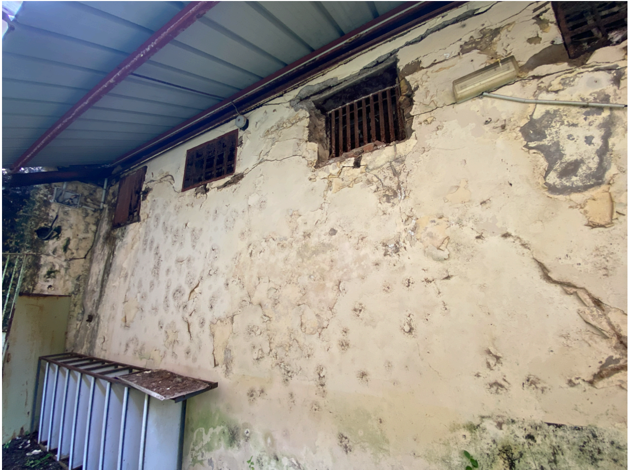
Arrière des dortoirs des condamnés primaires, détail de la maçonnerie de briques enduite témoignant de l'ancienneté de la construction
