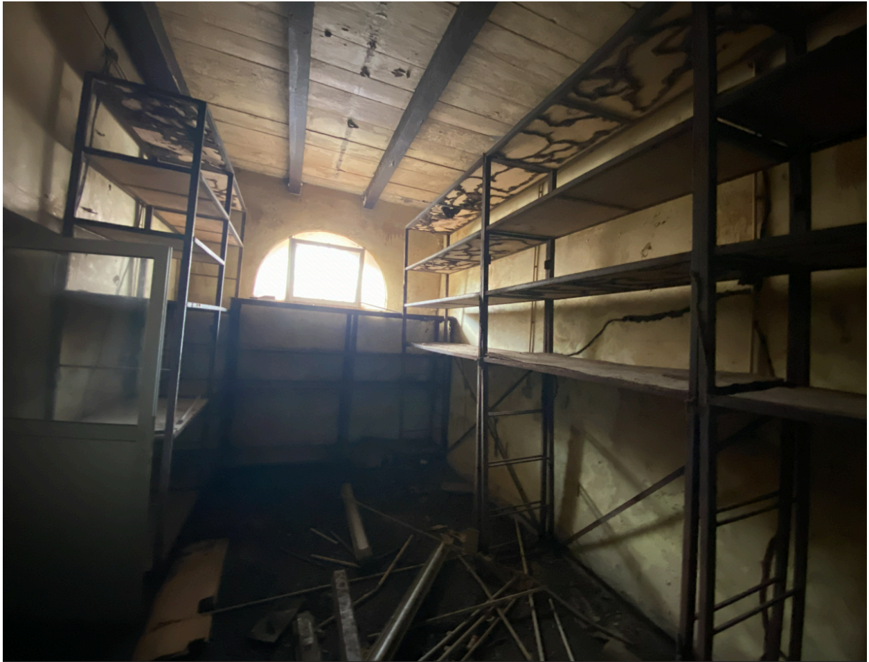
Vue d'une salle du rez-de-chaussée du pavillon central, état en mai 2026
