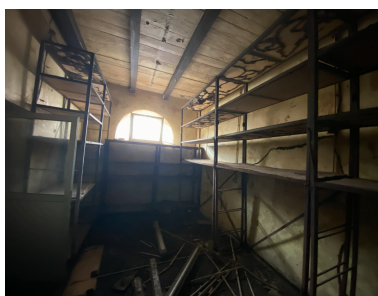
Vue d'une salle du rez-de-chaussée du pavillon central, état en mai 2026 Phot. Lionel Besnard IVR03_202697300068NUCA
