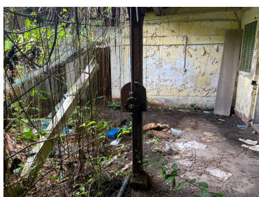
Quartier des femmes, détail de la pompe à eau Japy, état en mai 2026. Phot. Lionel Besnard IVR03_202697300092NUCA
