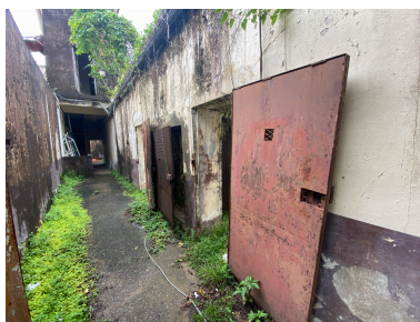
Couloir central de distribution et surveillance, avec le belvédère, depuis l'est vers l'ouest, état en mai 2026 Phot. Lionel Besnard IVR03_202697300071NUCA
