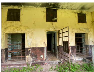
Quartier disciplinaire, vue d'ensemble, état en mai 2026. Phot. Lionel Besnard IVR03_202697300086NUCA
