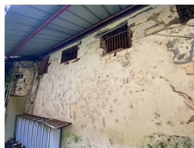
Arrière des dortoirs des condamnés primaires, détail de la maçonnerie de briques enduite témoignant de l'ancienneté de la construction Phot. Lionel Besnard IVR03_202697300090NUCA
