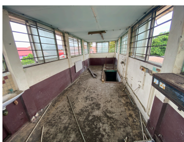
belvédère de surveillance, intérieur, état en mai 2026 Phot. Lionel Besnard IVR03_202697300073NUCA
