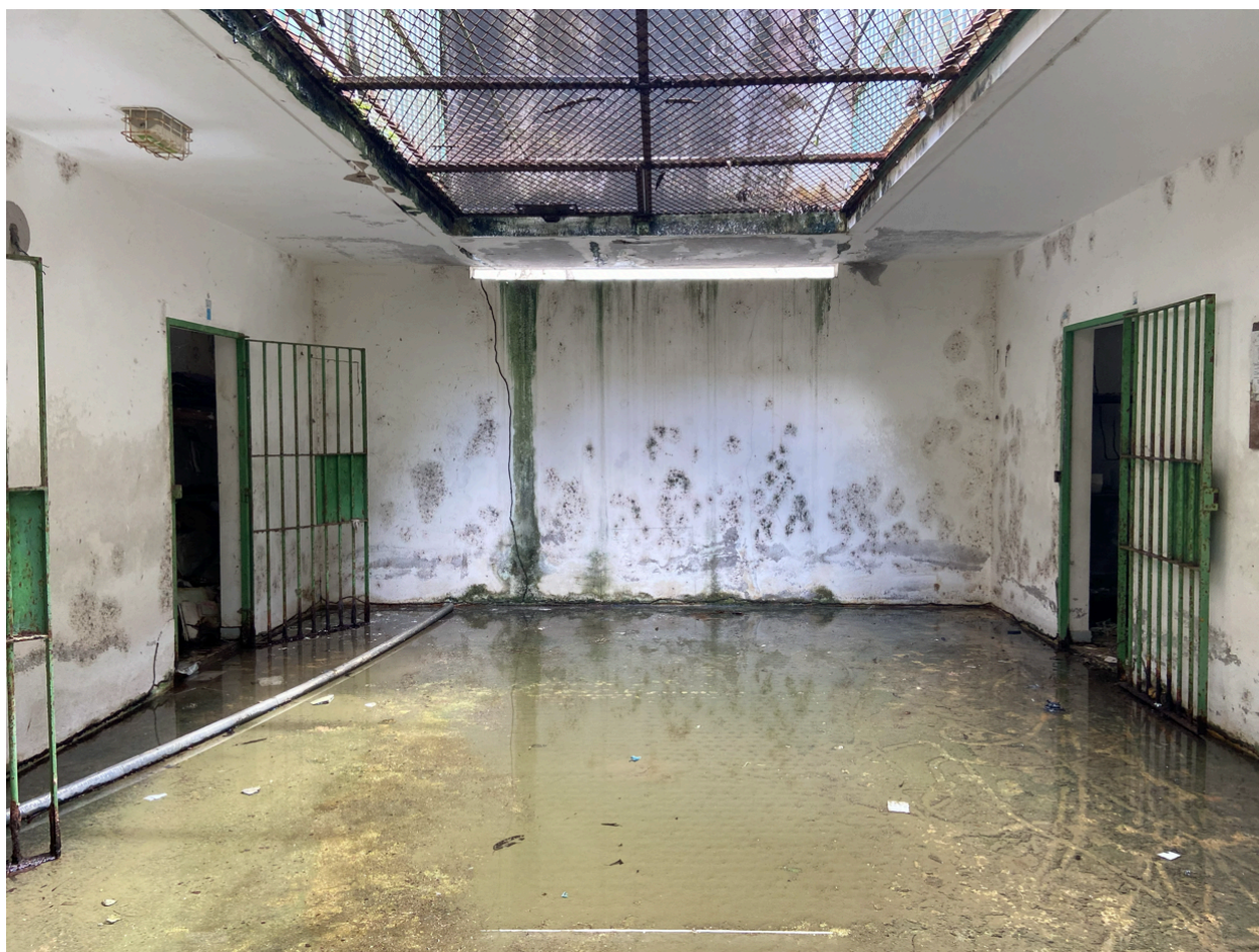
Extension de la fin de 20e siècle, une cour, état en mai 2026.
