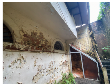
Vue du mur nord du pavillon central, avec bandeau de briques et lucarnes correspondant à l'enveloppe initiale du bâti Phot. Lionel Besnard IVR03_202697300065NUCA
