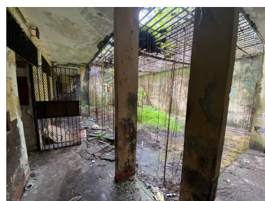
Angle nord-est de l'enceinte, quartier des mineurs, vue de la cour, état en mai 2026. Phot. Lionel Besnard IVR03_202697300093NUCA
