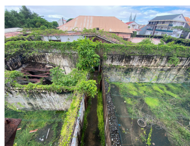
Vue du couloir et du toit du pavillon central depuis le belvédère, état en mai 2026. Phot. Lionel Besnard IVR03_202697300074NUCA
