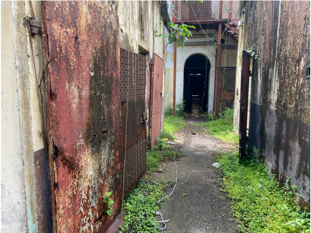
Couloir central de distribution et de surveillance, depuis l'ouest vers le pavillon central, état en mai 2026
