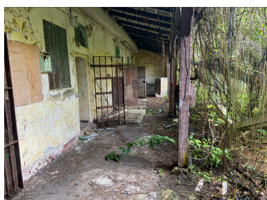
Angle sud-est de l'enceinte, quartier des femmes, état en mai 2026. Phot. Lionel Besnard IVR03_202697300091NUCA
