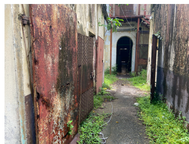
Couloir central de distribution et de surveillance, depuis l'ouest vers le pavillon central, état en mai 2026 Phot. Lionel Besnard IVR03_202697300072NUCA
