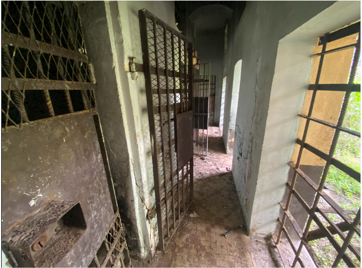
Quartier disciplinaire, porche des trois cellules, état en mai 2026.
