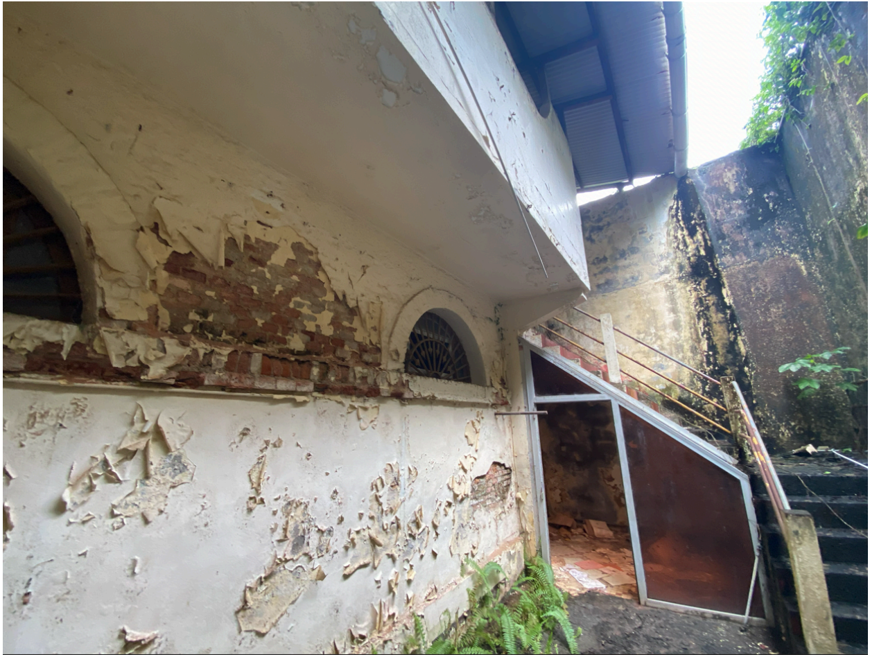
Vue du mur nord du pavillon central, avec bandeau de briques et lucarnes correspondant à l'enveloppe initiale du bâti
