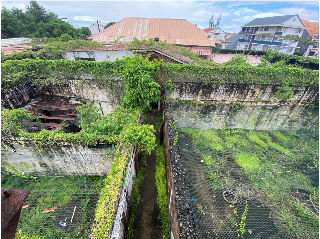
Vue du couloir et du toit du pavillon central depuis le belvédère, état en mai 2026.
