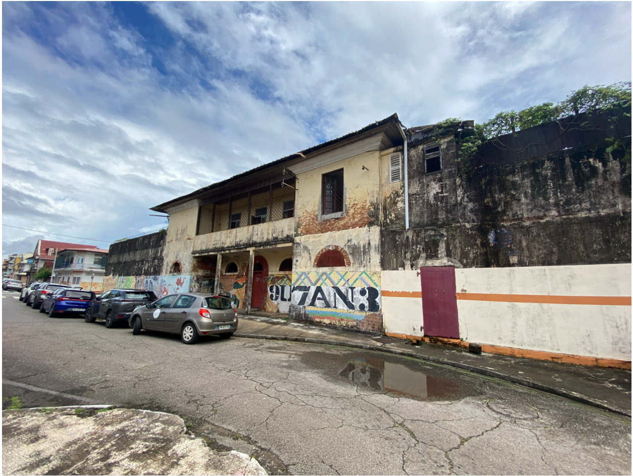
Vue générale de la façade ouest, rue Arago, état en mai 2026
