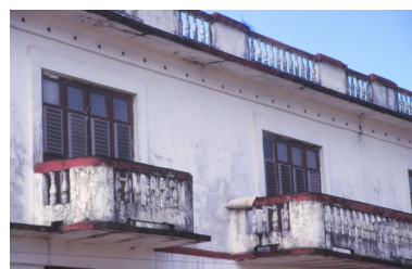
Détail des balcons et des garde-corps en ciment moulé Phot. Sylvie Réol IVR03_199897300182ZA
