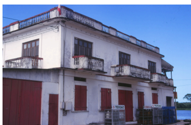
Façade sud en 1998 depuis la place Yves Patient Phot. Sylvie Réol IVR03_199897300181ZA
