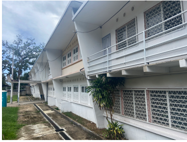
Détail de la façade nord avec son contre-fruit permettant un brise-soleil et une protection contre la pluie, novembre 2025
