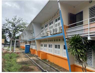
La façade en cours de travaux, mai 2026 Phot. Lionel Besnard IVR03_202697300117NUCA
