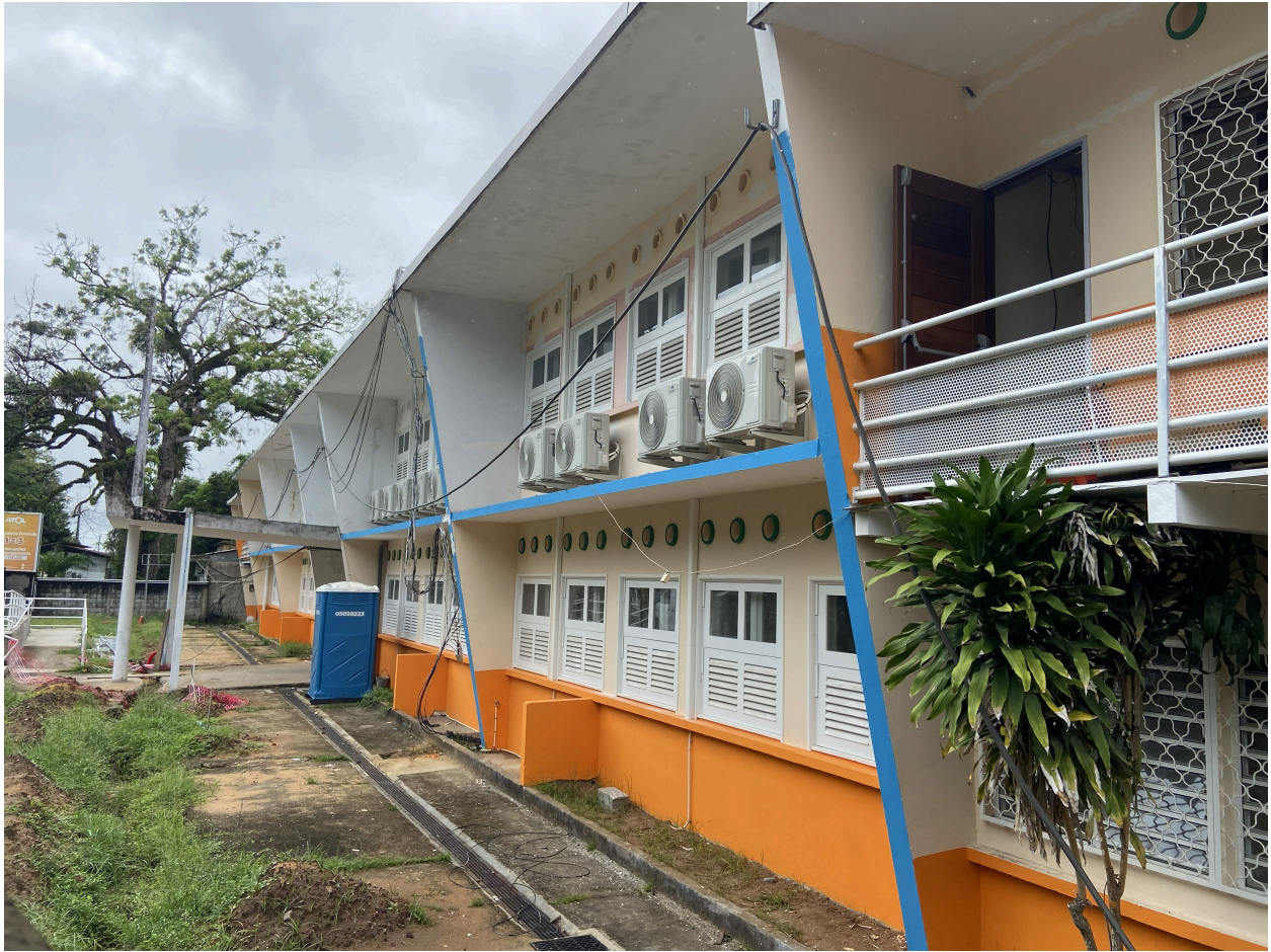
La façade en cours de travaux, mai 2026
