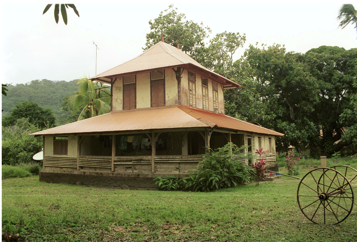
Vue latérale depuis l'est avec lames ventilantes sur la galerie, état en 2001
