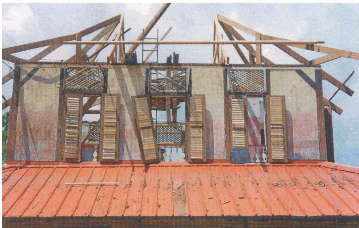
Réfection du toit en 1998, détail
