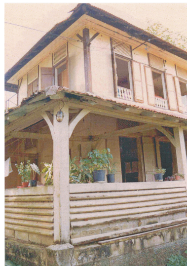
Détail de la galerie périphérique comportant un garde-corps à lames ventilantes, état en 1998 Phot. Yvon Lentin IVR03_202697300188NUCA
