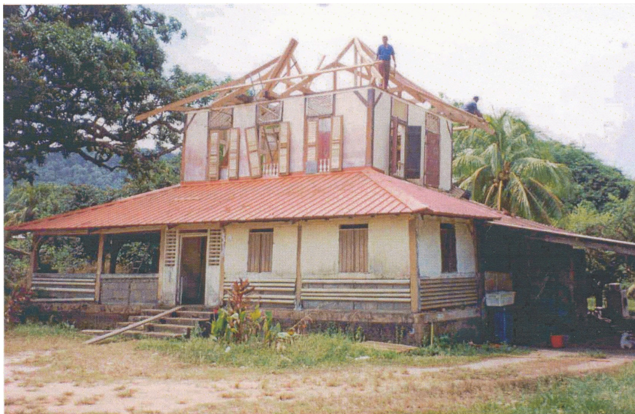
Réfection de la charpente en 1998
