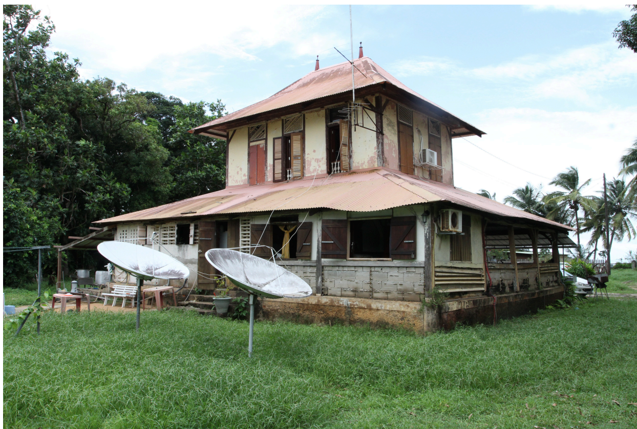
Vue depuis le sud, état en 2016
