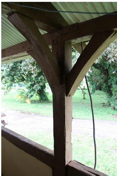
Détail d'un ensemble poteau-aisselier dans la galerie Phot. Kristen Sarge IVR03_202697300194NUCA
