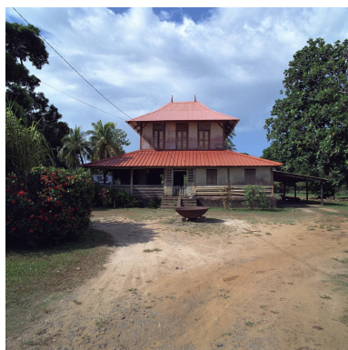
Vue générale, état en 2001 Phot. Marc Heller
