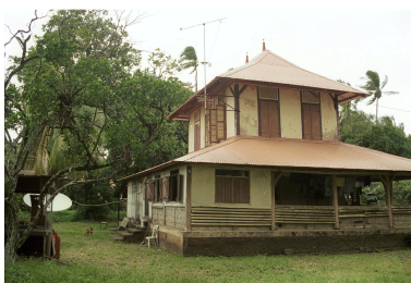
Vue depuis le sud-est, lames ventilantes sur la galerie, état en 2001 Phot. Marie-Pascale Mallé IVR03_200197300076ZE
