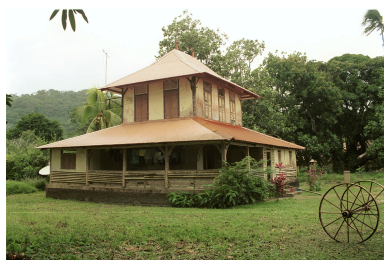
Vue latérale depuis l'est avec lames ventilantes sur la galerie, état en 2001 Phot. Marie-Pascale Mallé IVR03_200197300078ZE
