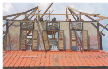
Réfection du toit en 1998, détail Phot. Yvon Lentin IVR03_202697300191NUCA
