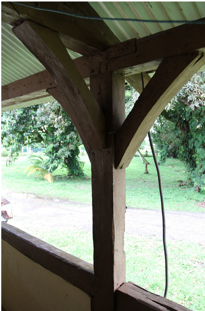
Détail d'un ensemble poteau-aisselier dans la galerie
