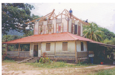
Réfection de la charpente en 1998 Phot. Yvon Lentin IVR03_202697300190NUCA
