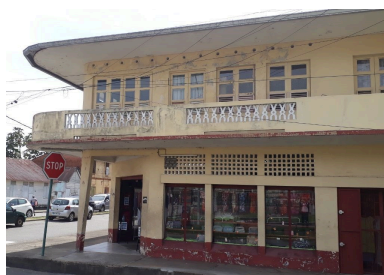
Vue depuis l'avenue du Général de Gaulle Phot. David Foucambert IVR03_202697300025NUCA
