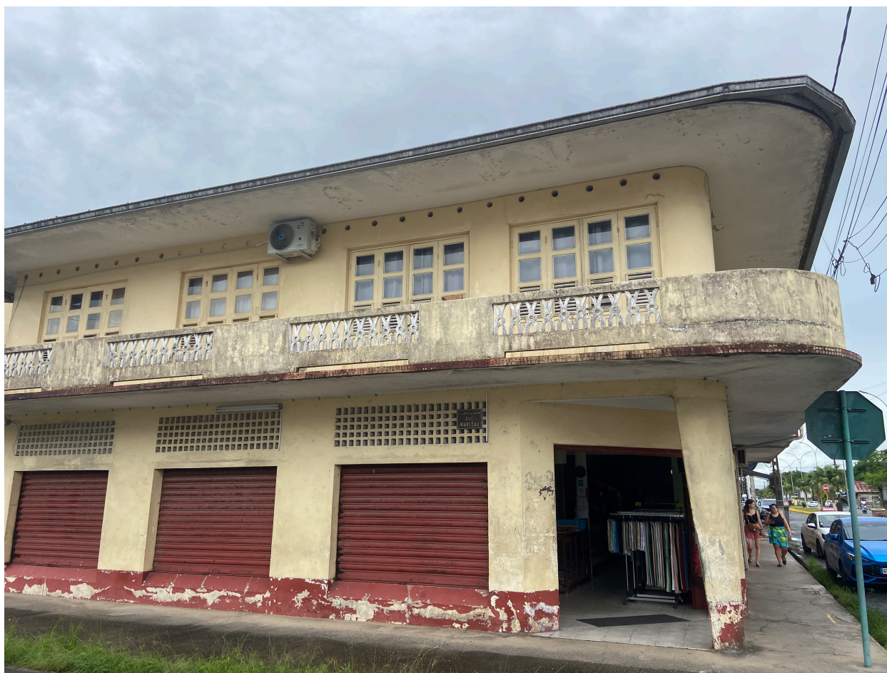
Façade nord sur la rue Marceau en 2025
