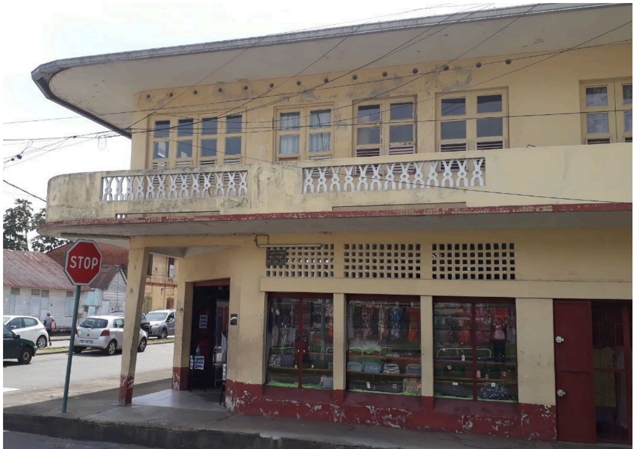
Vue depuis l'avenue du Général de Gaulle
