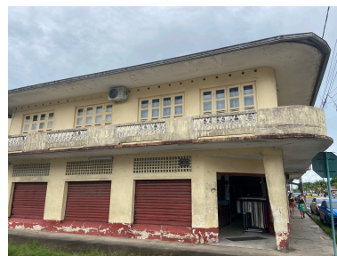
Façade nord sur la rue Marceau en 2025 Phot. Lionel Besnard IVR03_202697300036NUCA
