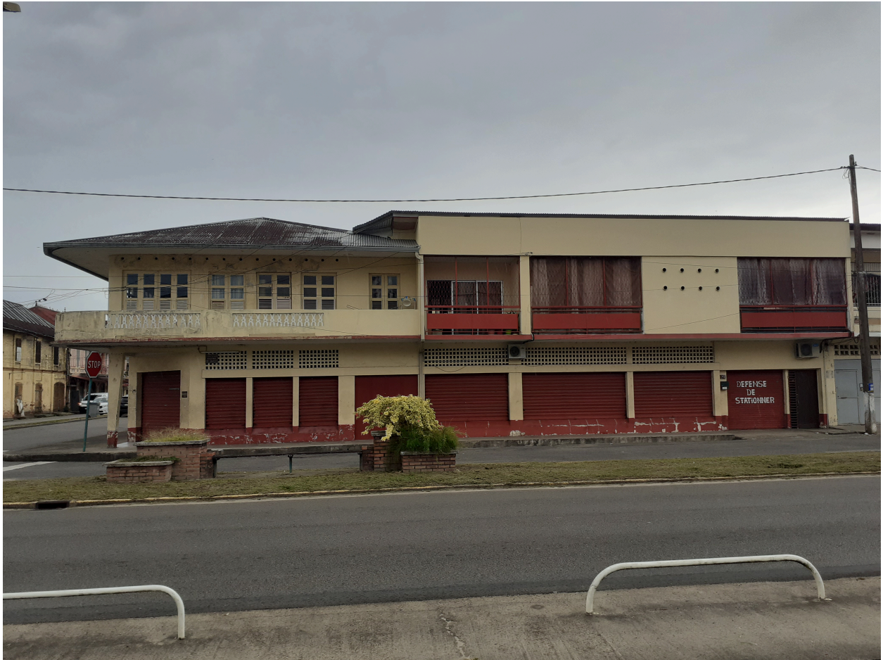
Vue d'ensemble de la façade ouest
