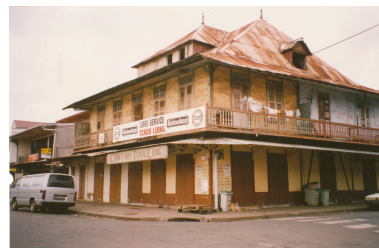
Vue générale en 1991, depuis le nord-ouest Phot. M. Lantonat IVR03_202697300174ZE
