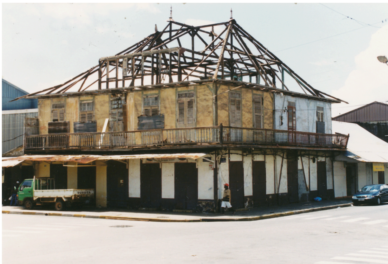
Vue de volume depuis le nord-ouest après enlèvement de la toiture, 2001
