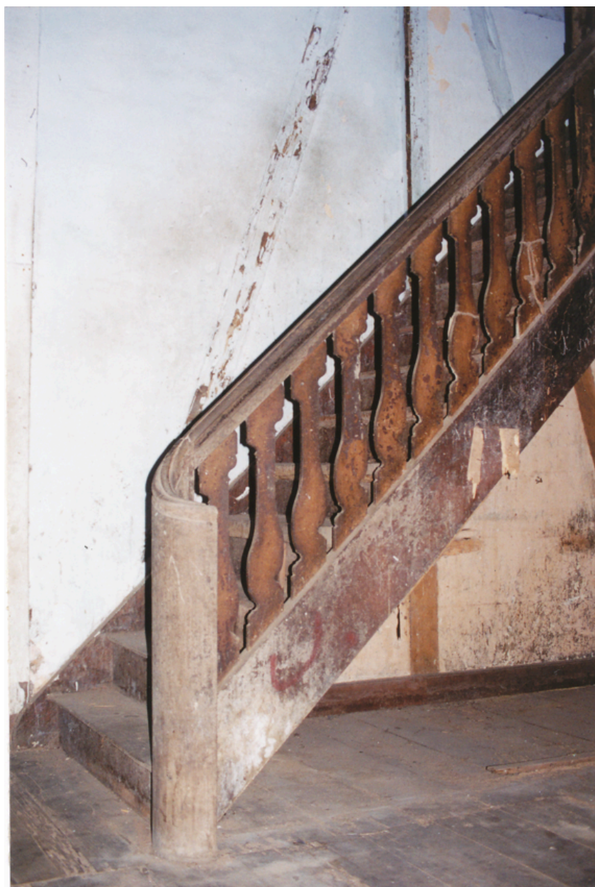
L'escalier intérieur en 2001, détail
