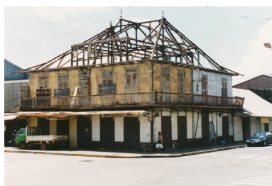
Vue de volume depuis le nord-ouest après enlèvement de la toiture, 2001 Phot. Marie-Pascale Mallé IVR03_200197300183ZE
