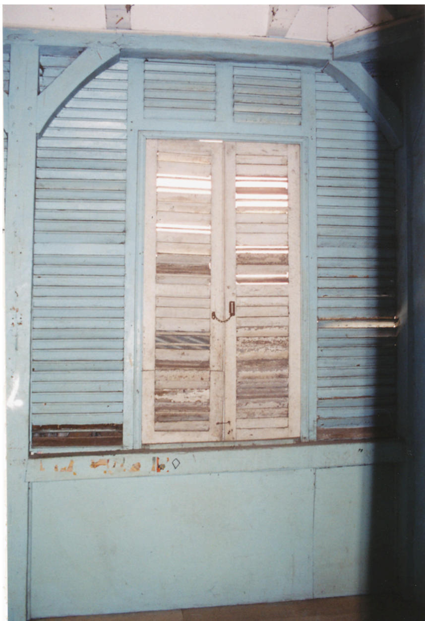
La vérandah du premier étage, détail d'une ouverture en 2001
