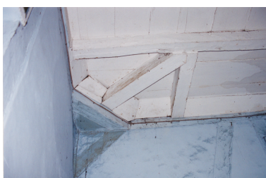
Le plafond d'une salle à l'étage en 2001, détail Phot. Marie-Pascale Mallé IVR03_200197300458ZE
