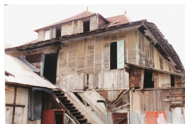
Façade sud sur jardin : la galerie du premier étage, en 2001 Phot. Marie-Pascale Mallé IVR03_200197300454ZE
