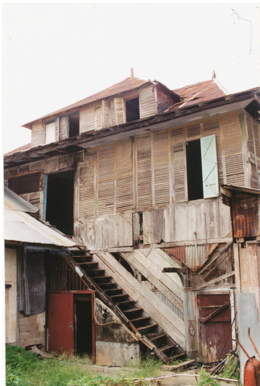
Façade sud sur jardin : l'escalier extérieur en 2001
