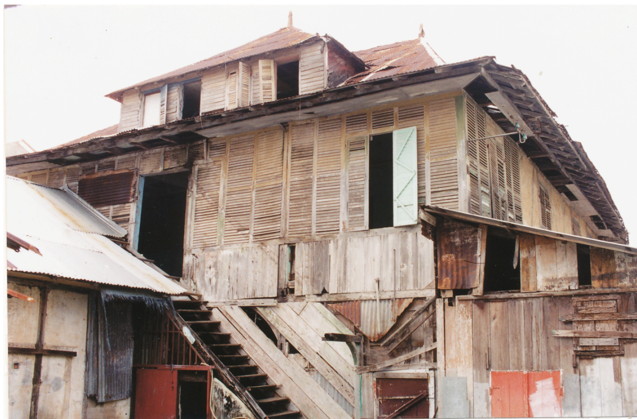
Façade sud sur jardin : la galerie du premier étage, en 2001
