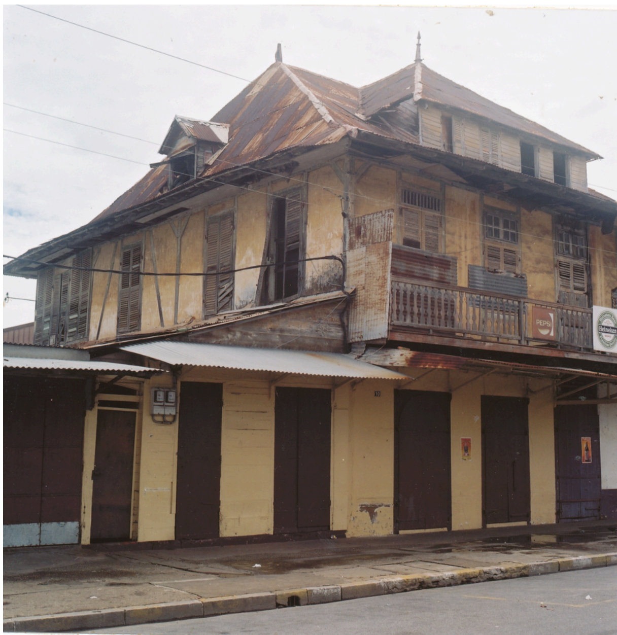
Vue de volume prise du nord-est en 2000
