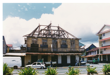
Façade nord : vue après enlèvement de la toiture Phot. Marie-Pascale Mallé IVR03_200197300182ZE
