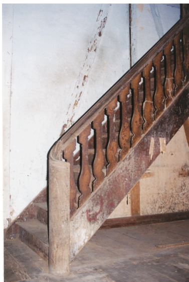
L'escalier intérieur en 2001, détail Phot. Marie-Pascale Mallé IVR03_200197300457ZE
