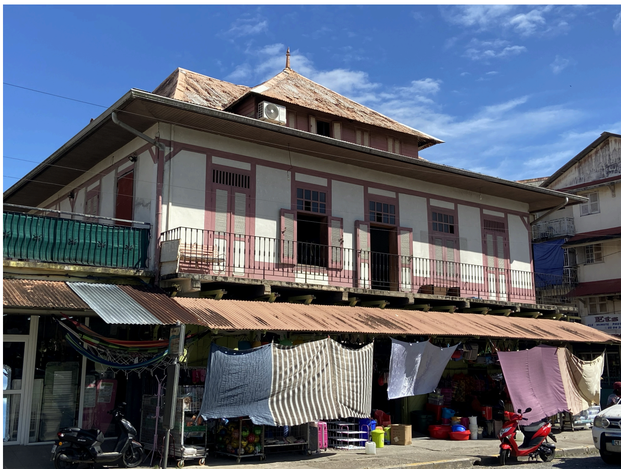
Vue générale depuis le nord-est, juillet 2026
