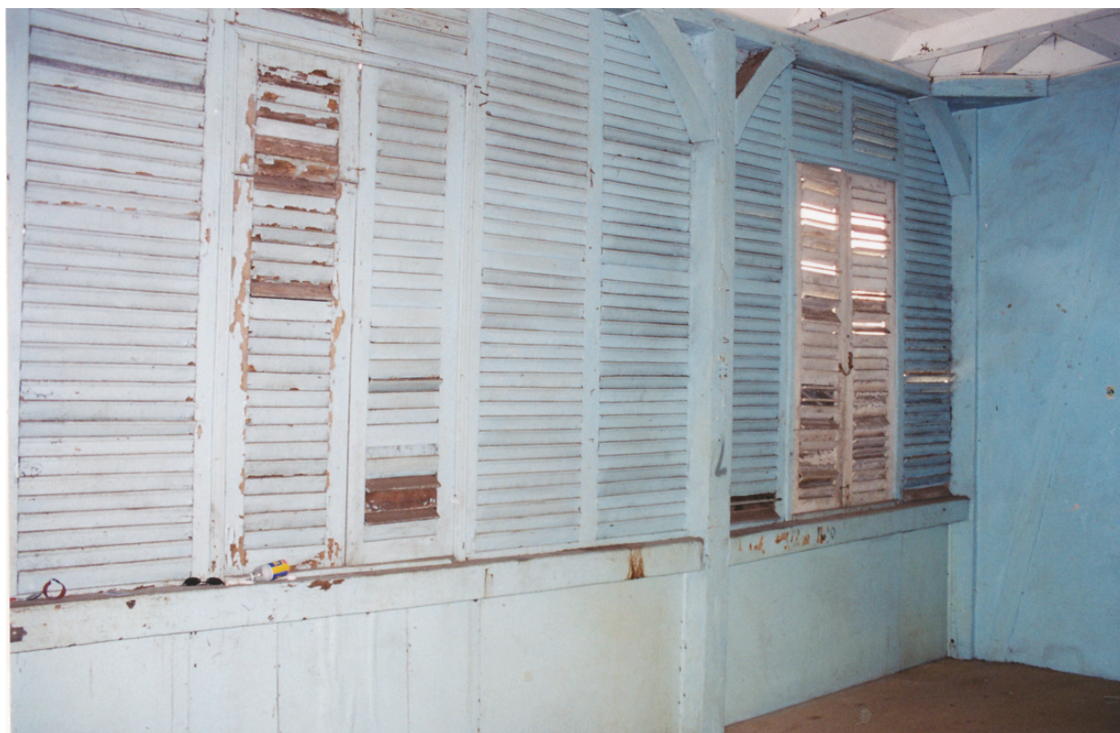
La vérandah du premier étage en 2001
