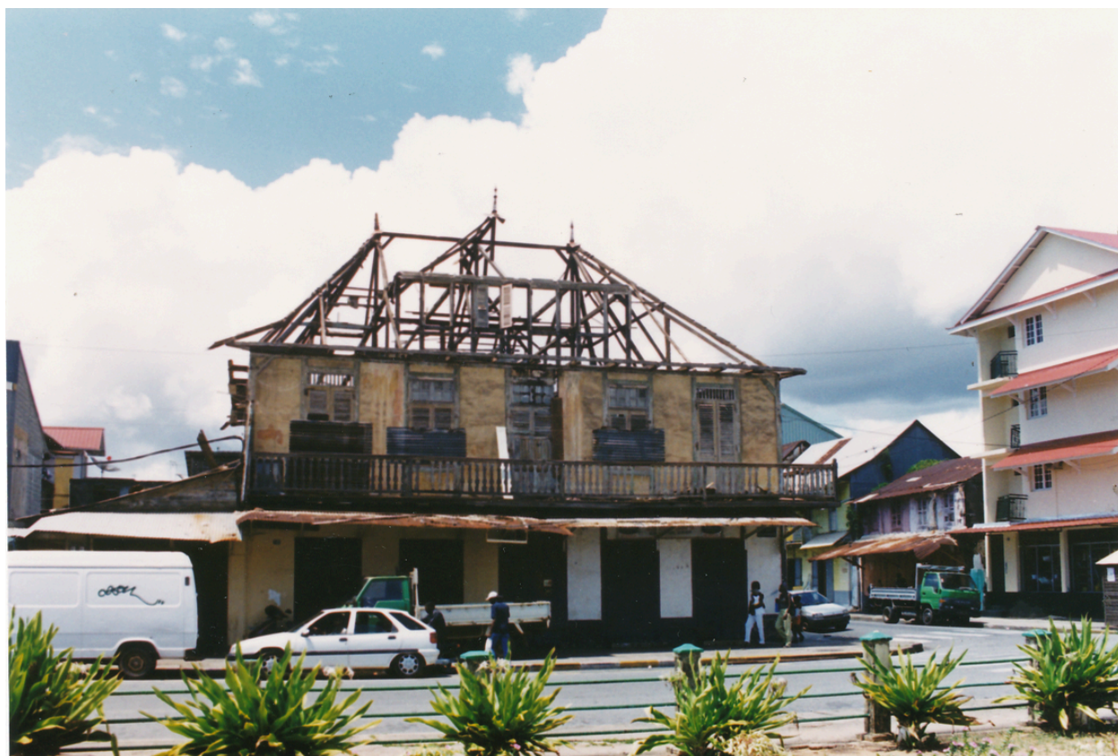
Façade nord : vue après enlèvement de la toiture
