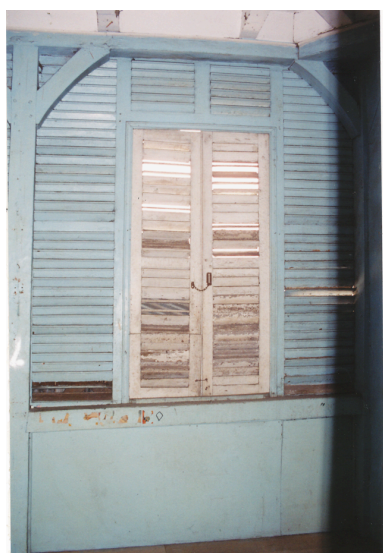
La vérandah du premier étage, détail d'une ouverture en 2001 Phot. Marie-Pascale Mallé IVR03_200197300459ZE
