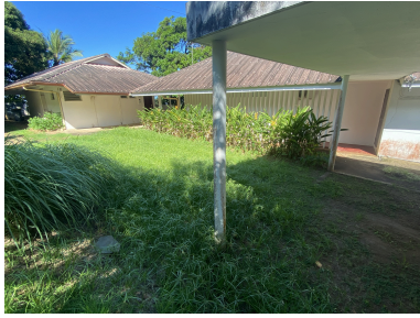
Vue générale de l'ensemble depuis le nord, juillet 2026 Phot. Lionel Besnard IVR03_202697300181NUCA
