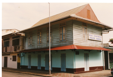
Vue de volume prise du nord-ouest, état en 2000. Phot. Sylvie Réol IVR03_202697300201NUCA
