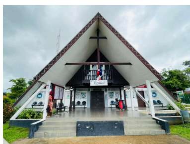
Façade, vue générale en juin 2026 Phot. Katrine Miranda IVR03_202697300118NUCA
