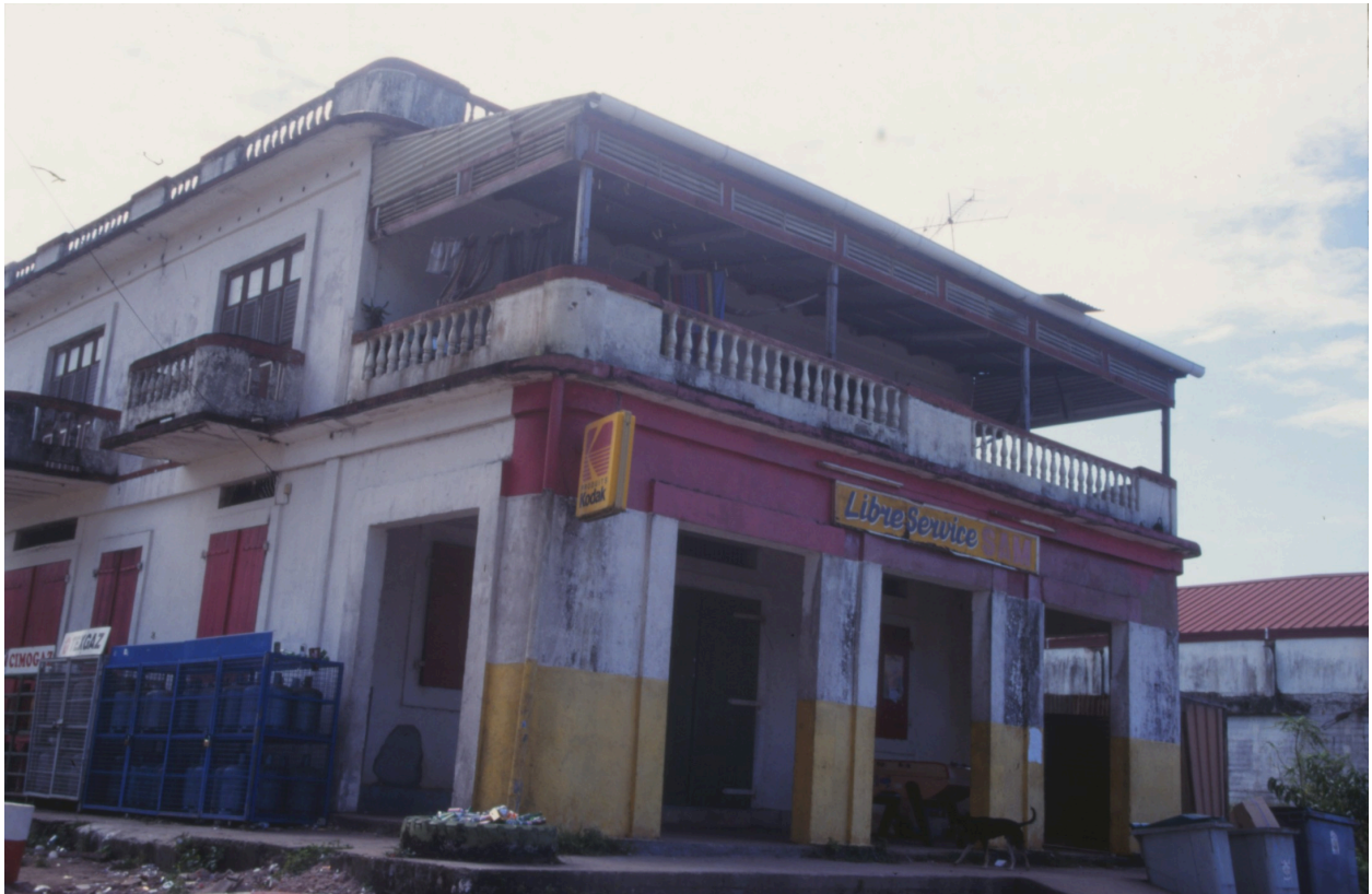
Vue du commerce et de la terrasse depuis le quai en 1998
