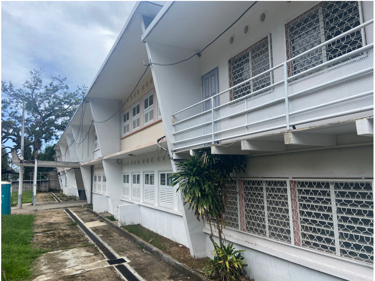
Détail de la façade nord avec son contre-fruit permettant un brise-soleil et une protection contre la pluie, novembre 2025
