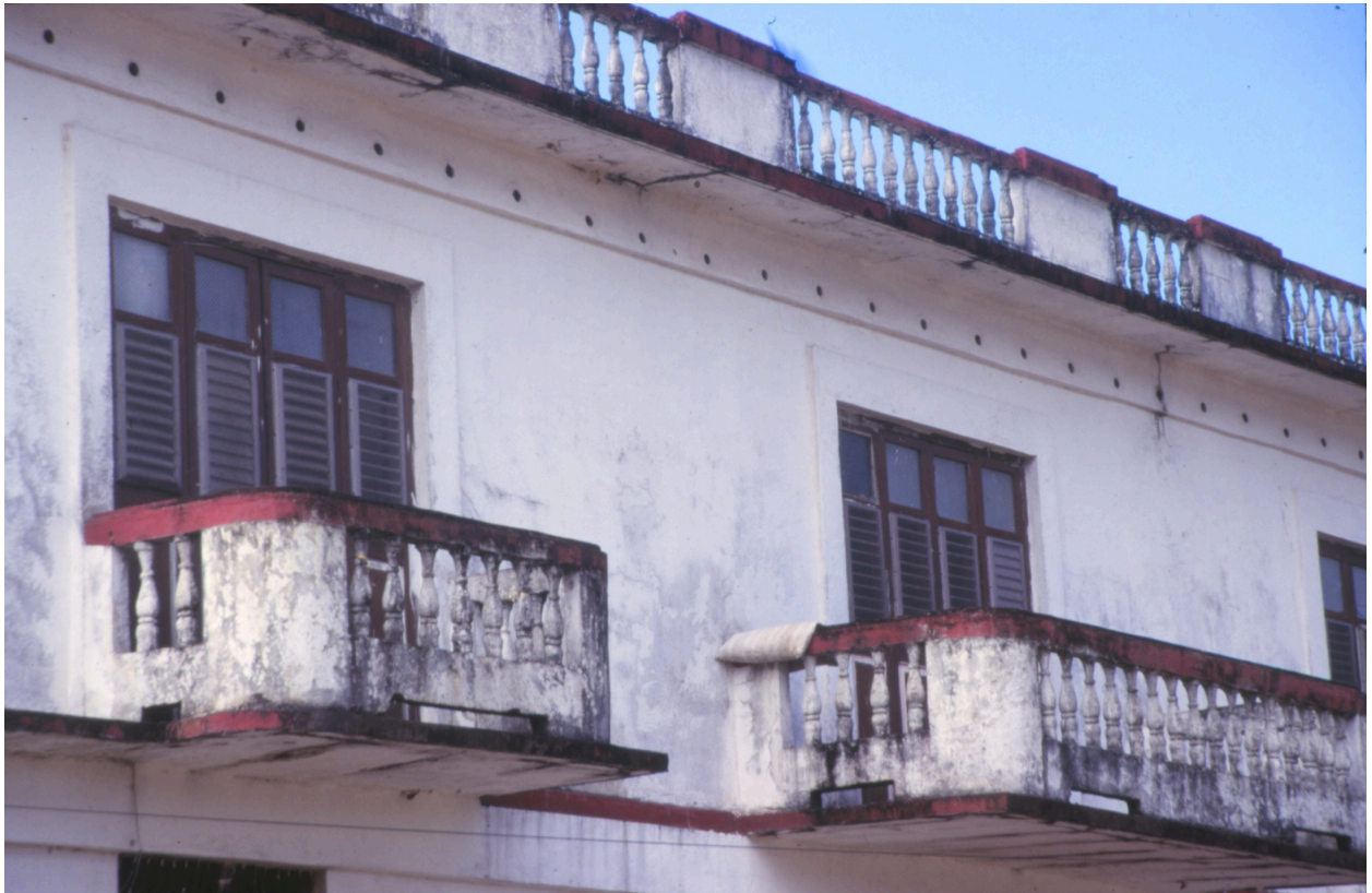
Détail des balcons et des garde-corps en ciment moulé
