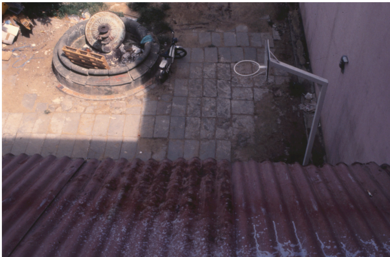
Vue de la cour depuis la galerie arrière, 1995
