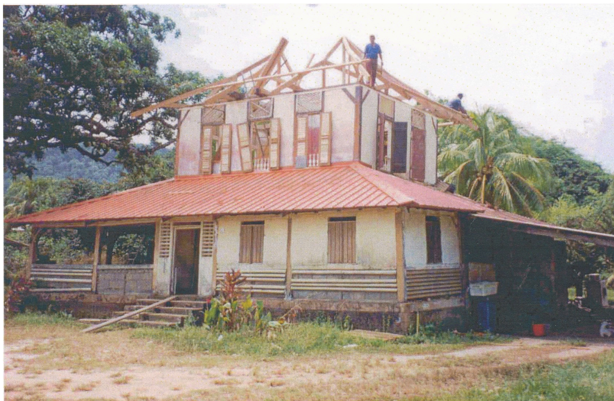
Réfection de la charpente en 1998
