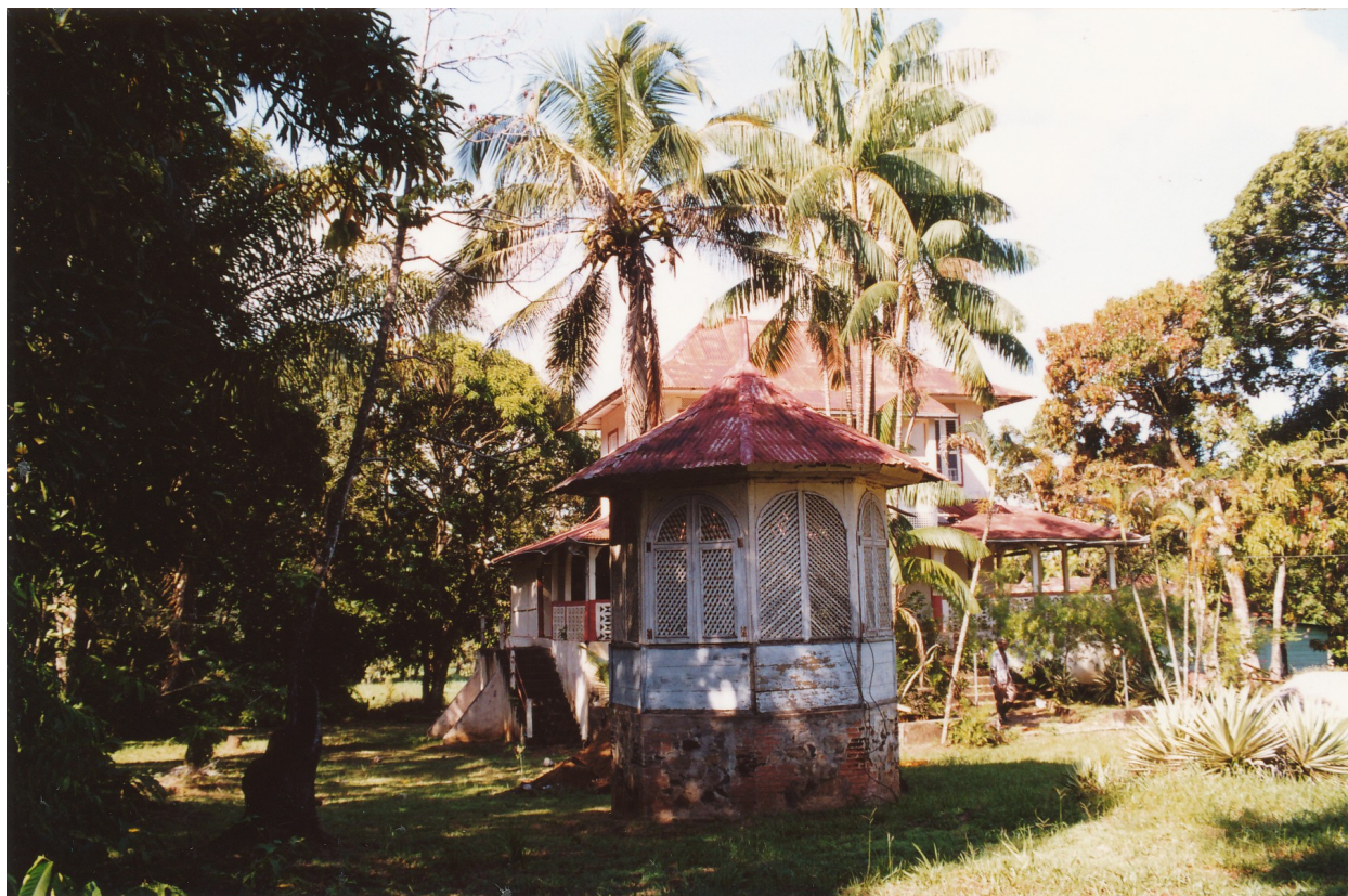
La façade ouest et la fabrique de jardin droite
