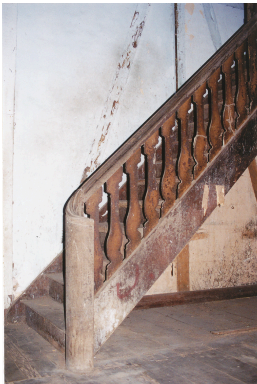
L'escalier intérieur en 2001, détail
