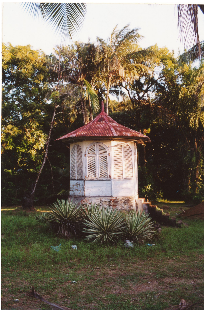
La fabrique de jardin gauche, réservée aux dames, état en 2002.
