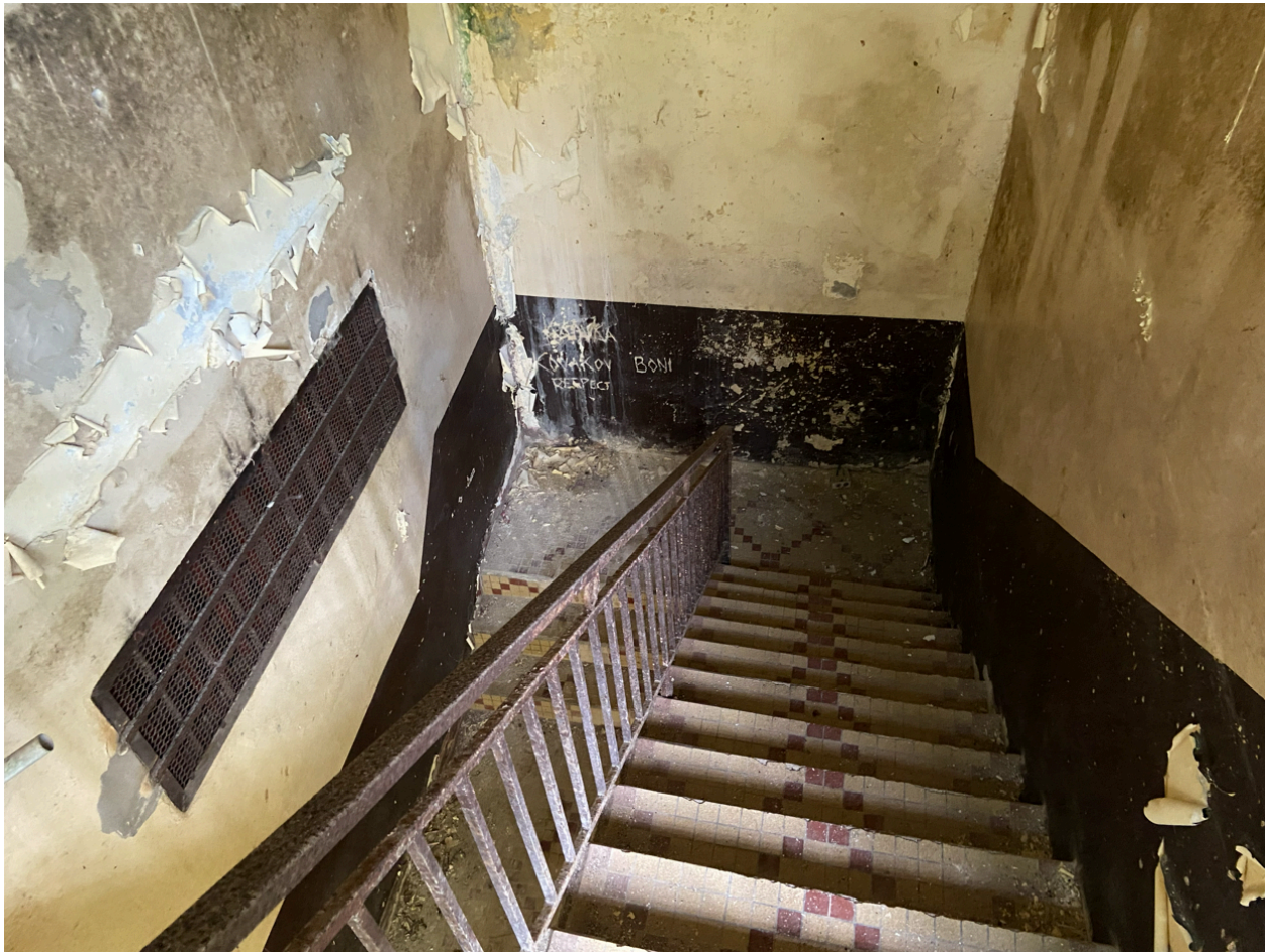
Quartier des mineurs, escalier d'accès à l'étage, état en mai 2026.
