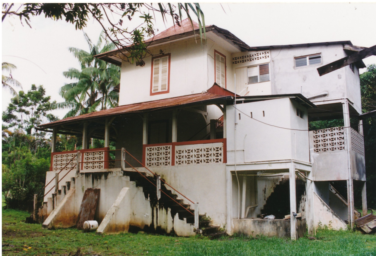
La façade ouest, état en 2002
