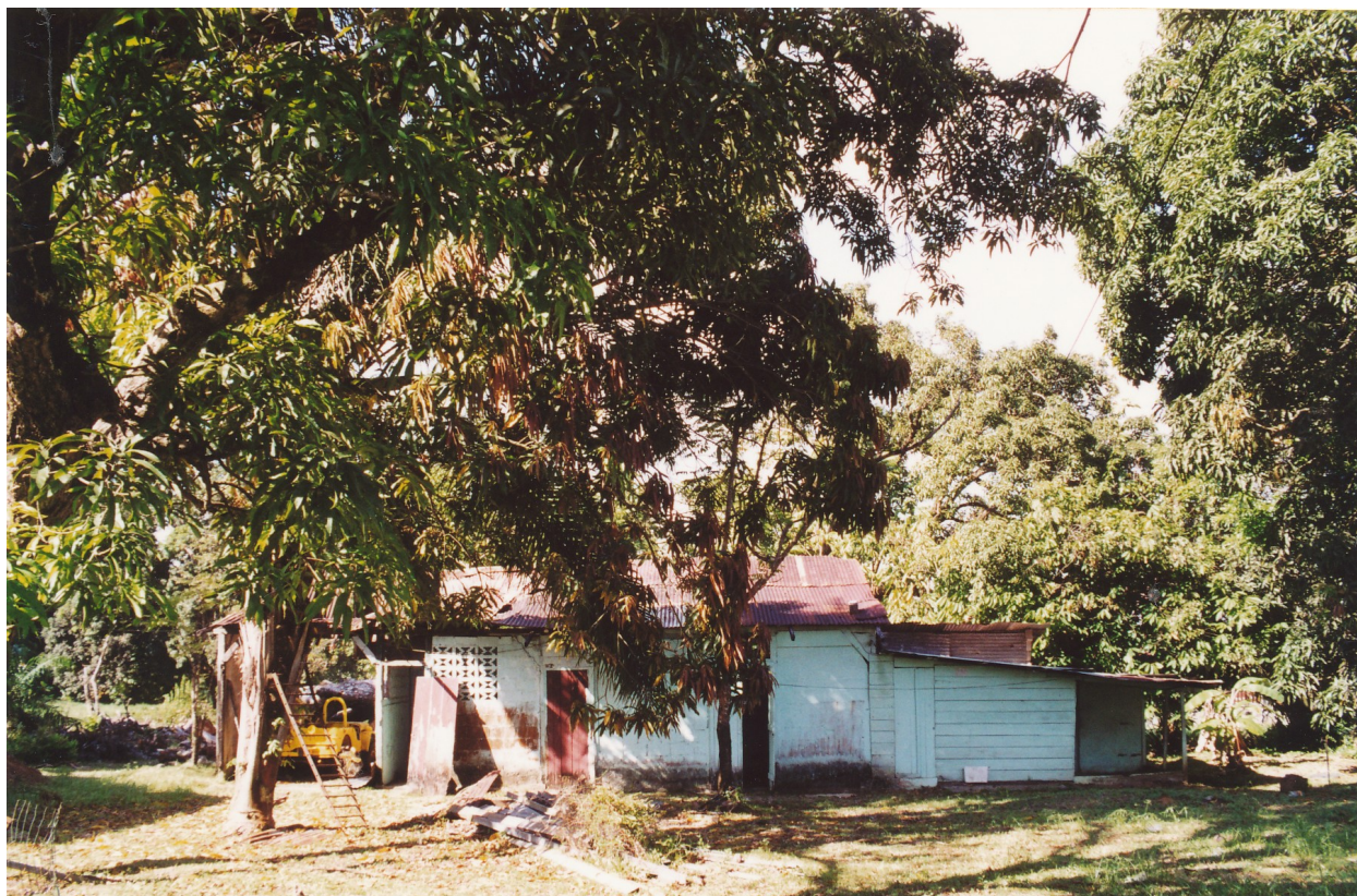
L'une des servitudes: façade nord, état en 2002
