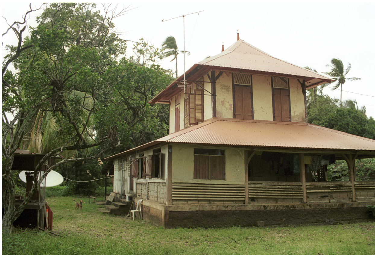
Vue depuis le sud-est, lames ventilantes sur la galerie, état en 2001
