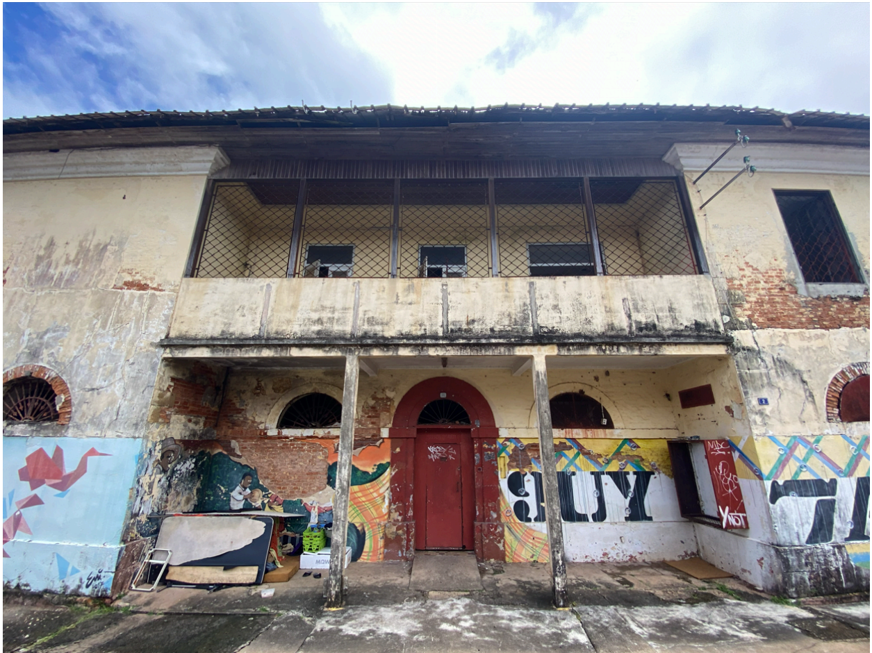
La façade rue Arago en mai 2026, détail de l'entrée
