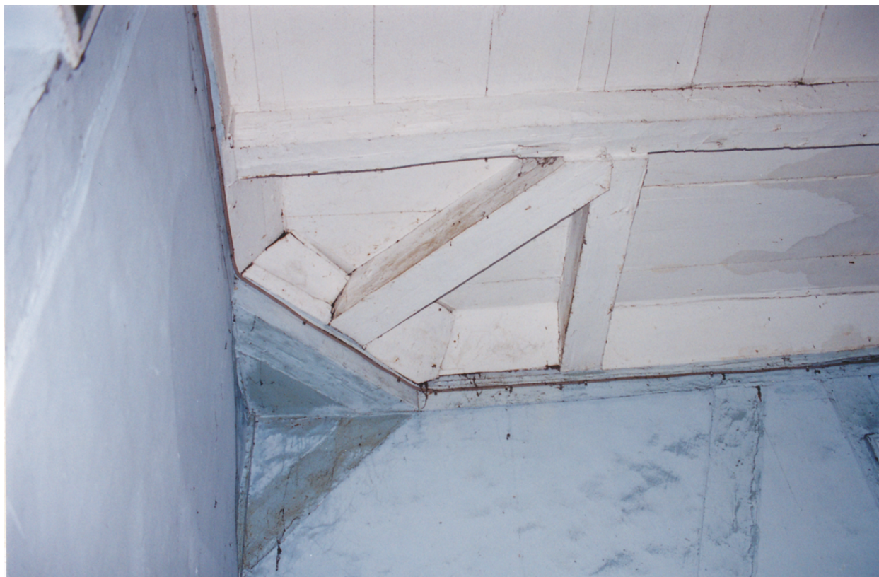
Le plafond d'une salle à l'étage en 2001, détail
