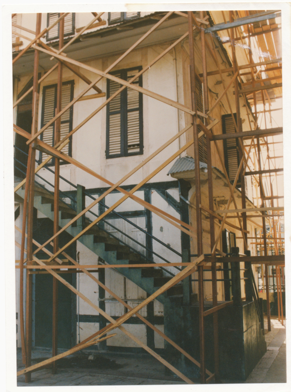
GUYANE CAYENNE Maison Vitalo Echafaudage pendant travaux
