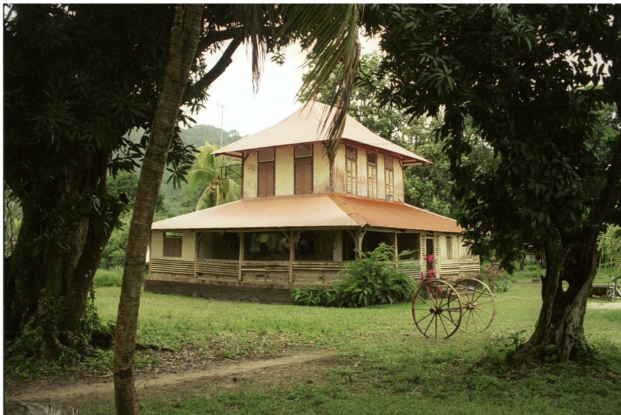
Vue de l'angle de la maison depuis l'allée des cocotiers, état en 2001
