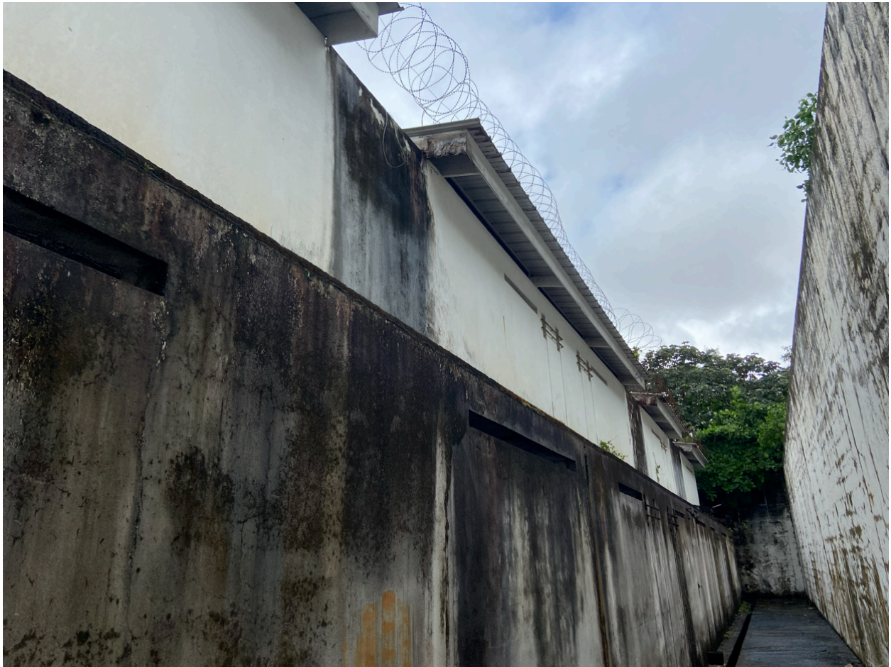
Chemin de ronde nord entre le mur d'enceinte nord et l'extension la plus récente, vers 1995, état en mai 2026.
