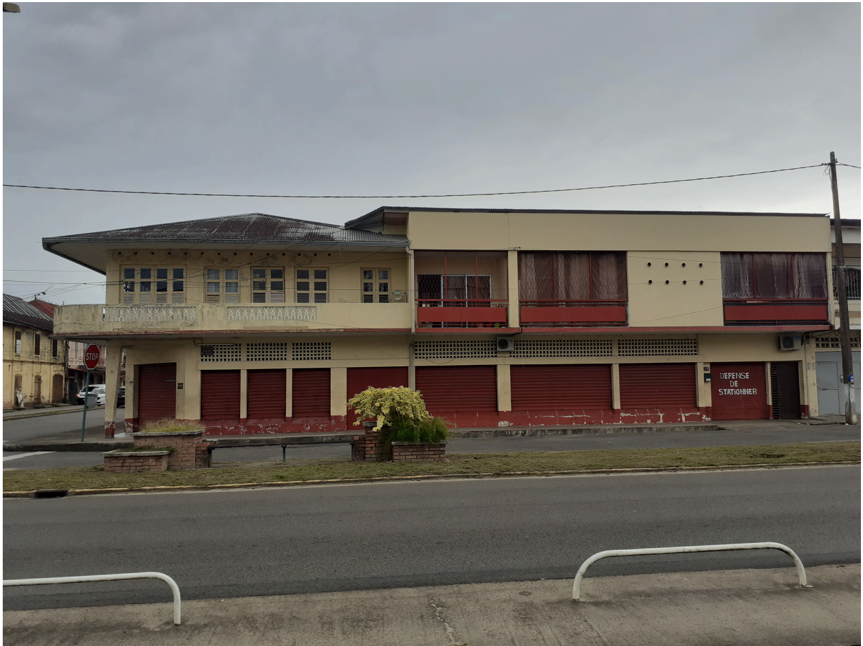
Vue d'ensemble de la façade ouest
