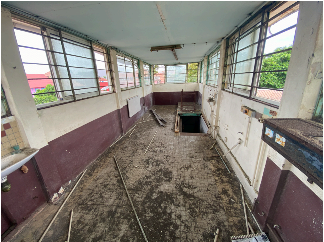
belvédère de surveillance, intérieur, état en mai 2026
