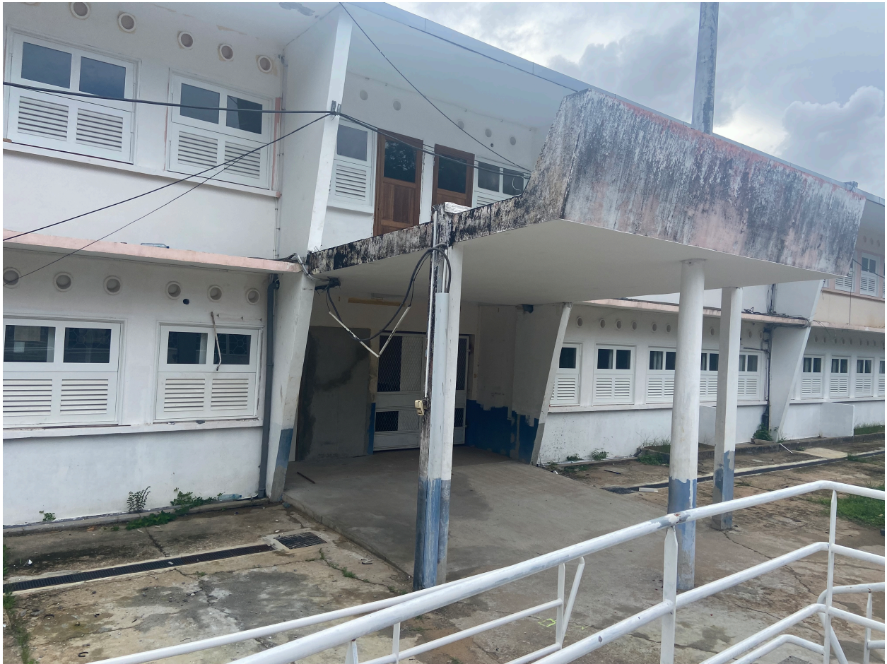
Détail de l'auvent d'entrée, novembre 2025
