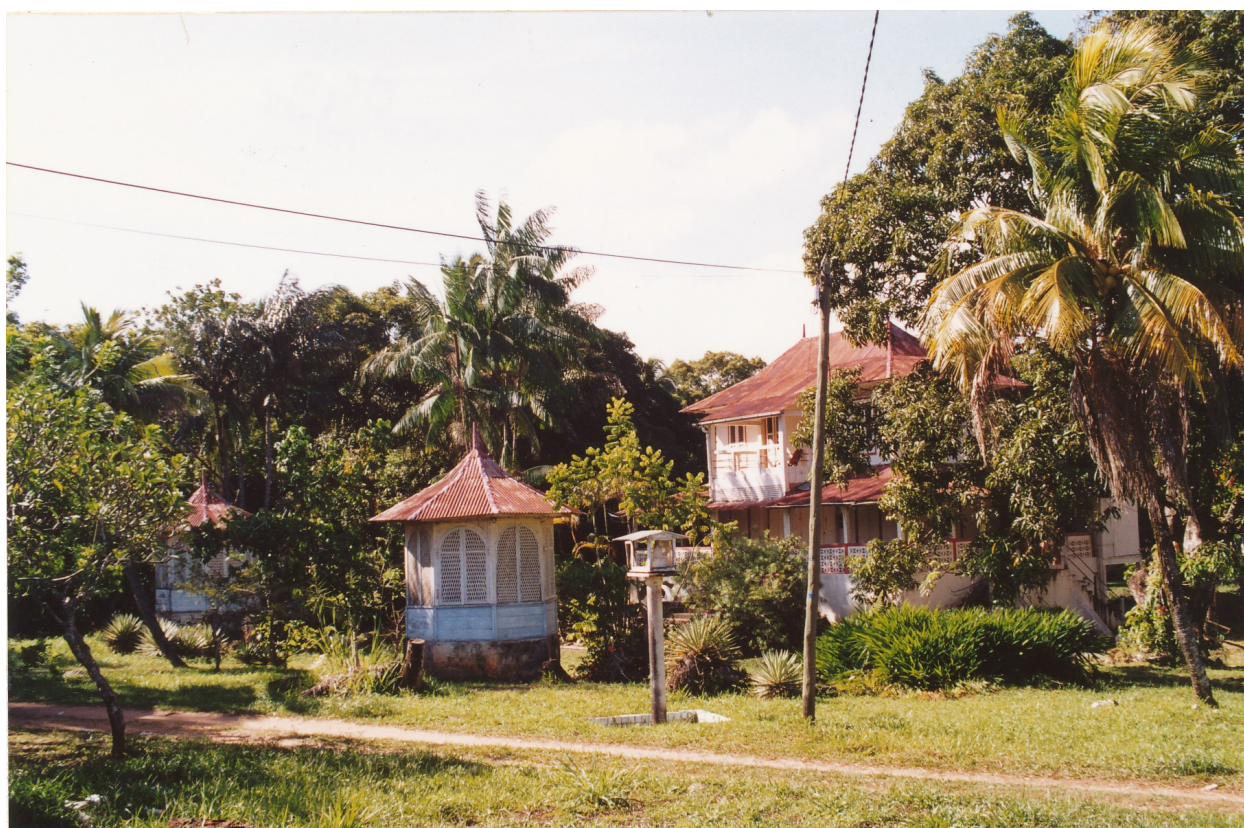
Vue d'ensemble prise du nord-est, état en 2002
