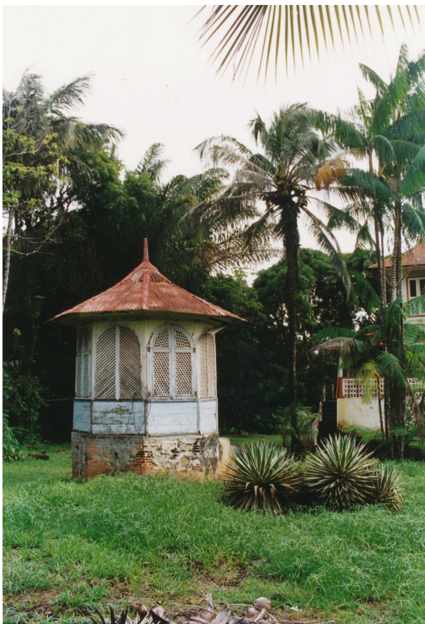
La fabrique de jardin gauche, état en 2002
