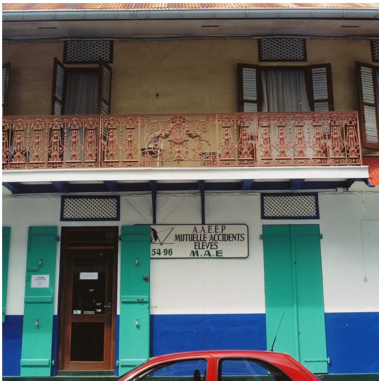
Façade sud, le balcon en ferronnerie en 2000.
