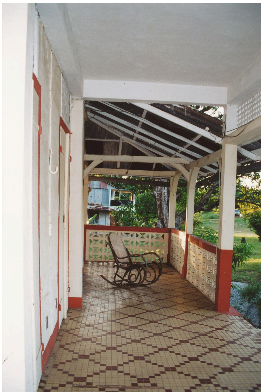
La galerie, vue intérieure, état en 2002.
