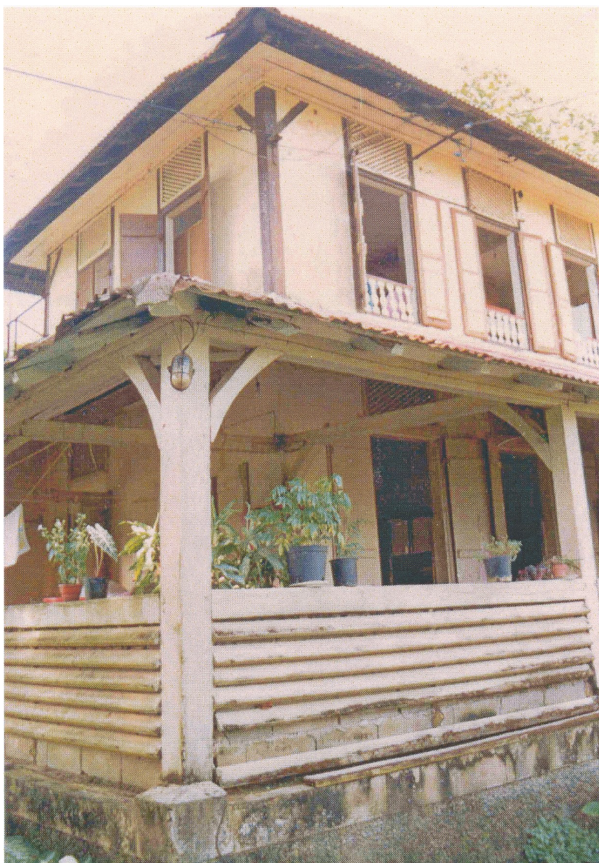
Détail de la galerie périphérique comportant un garde-corps à lames ventilantes, état en 1998
