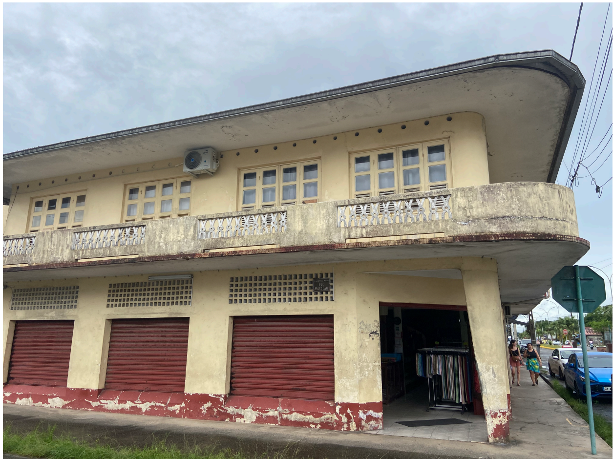
Façade nord sur la rue Marceau en 2025
