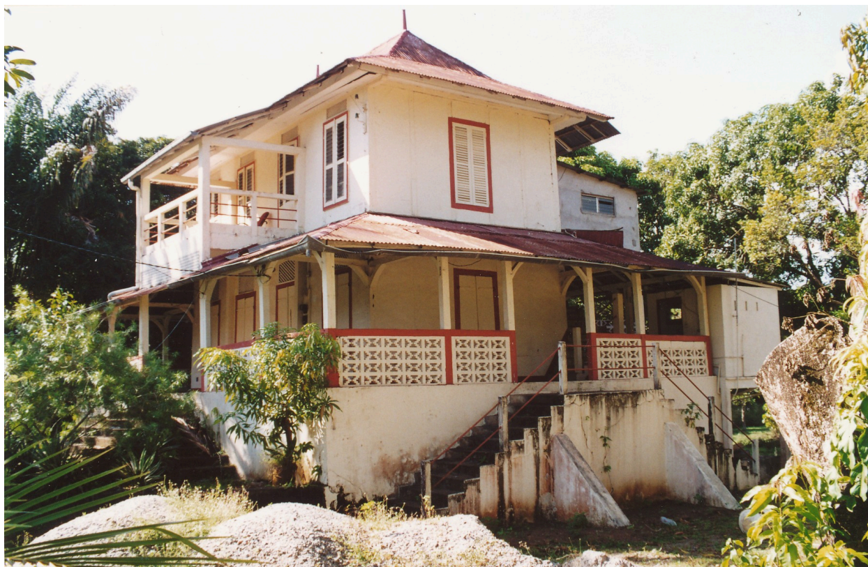
La maison de maître, vue prise du nord
