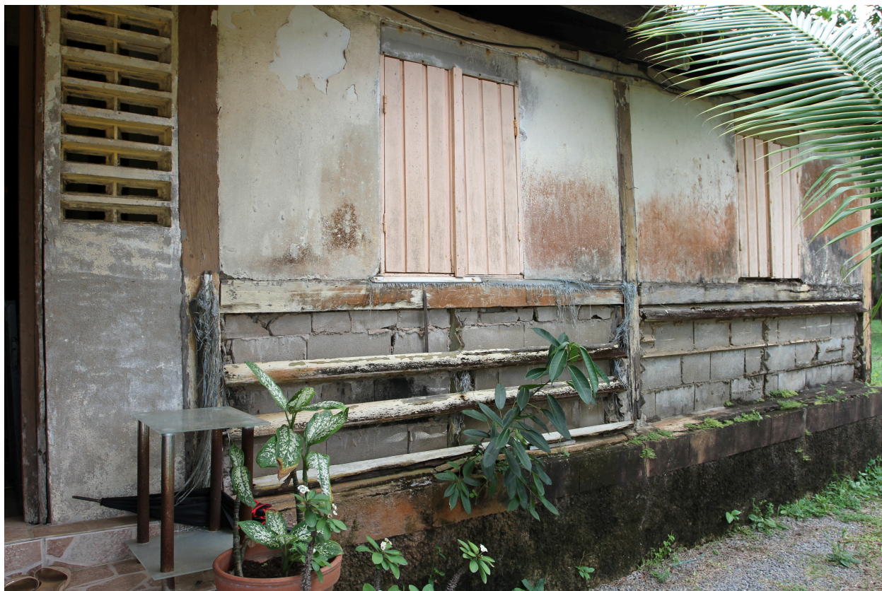
Détail de la façade postérieure où des parpaings remplacent les lames ventilantes, état en 2016
