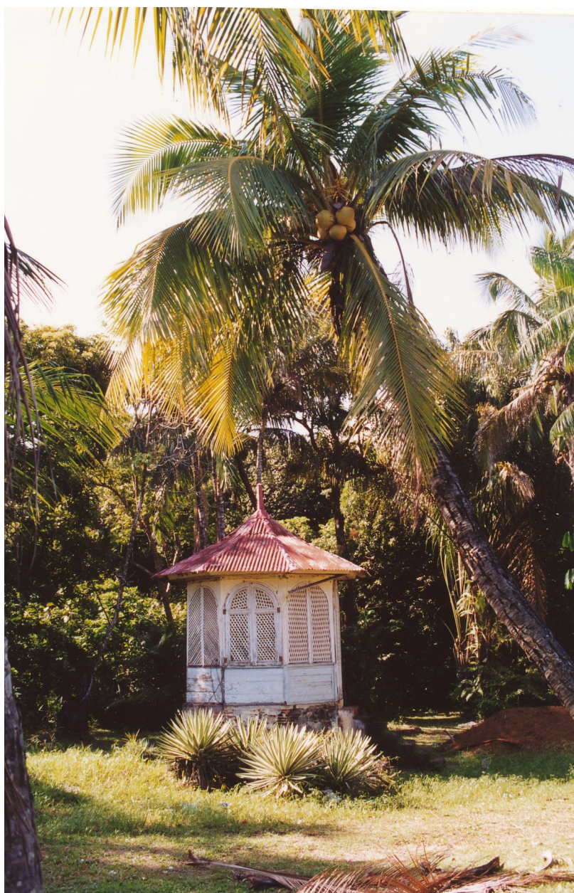
La fabrique de jardin de gauche, état en 2002
