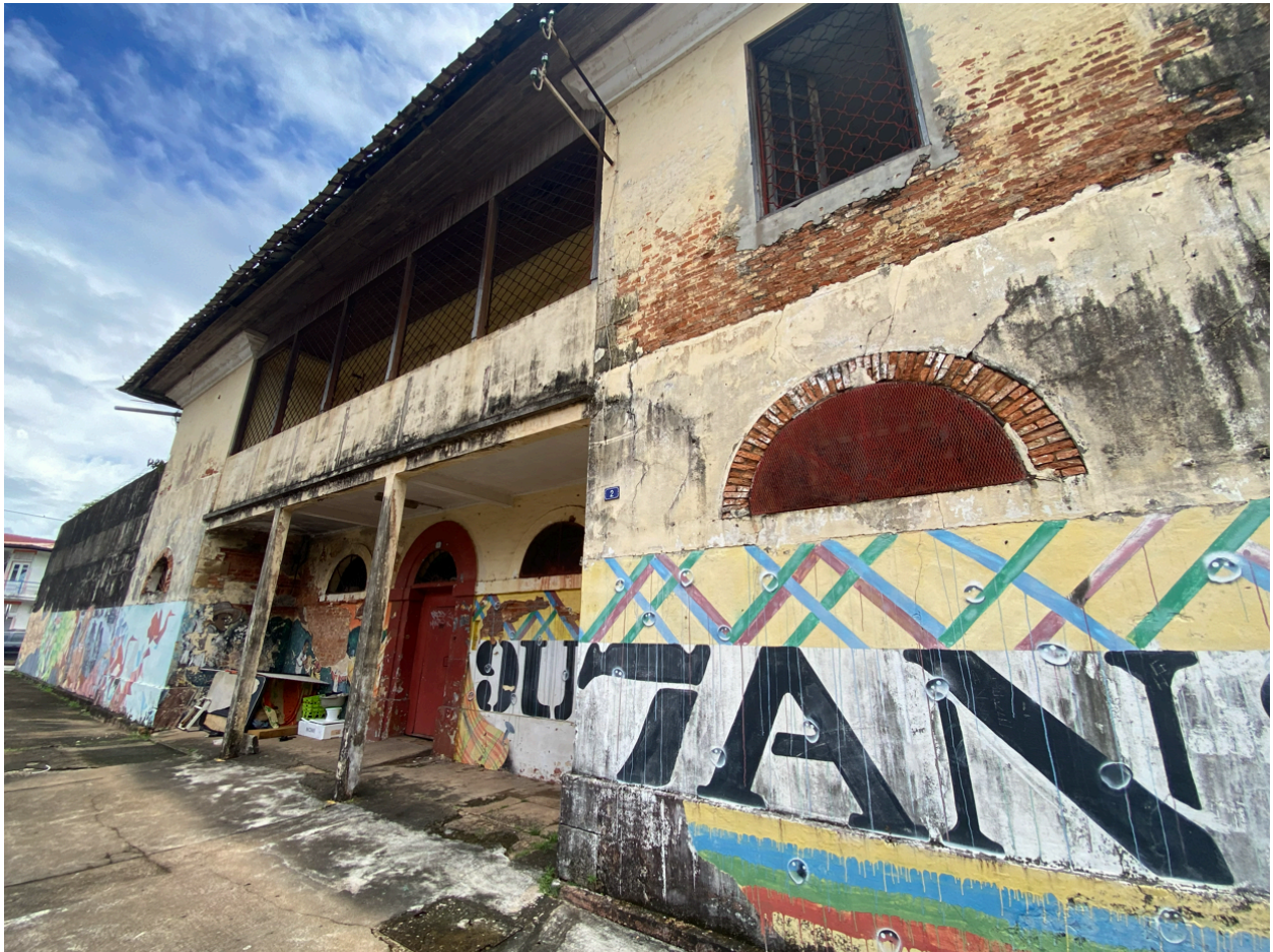
Façade est rue Arago, état en mai 2026
