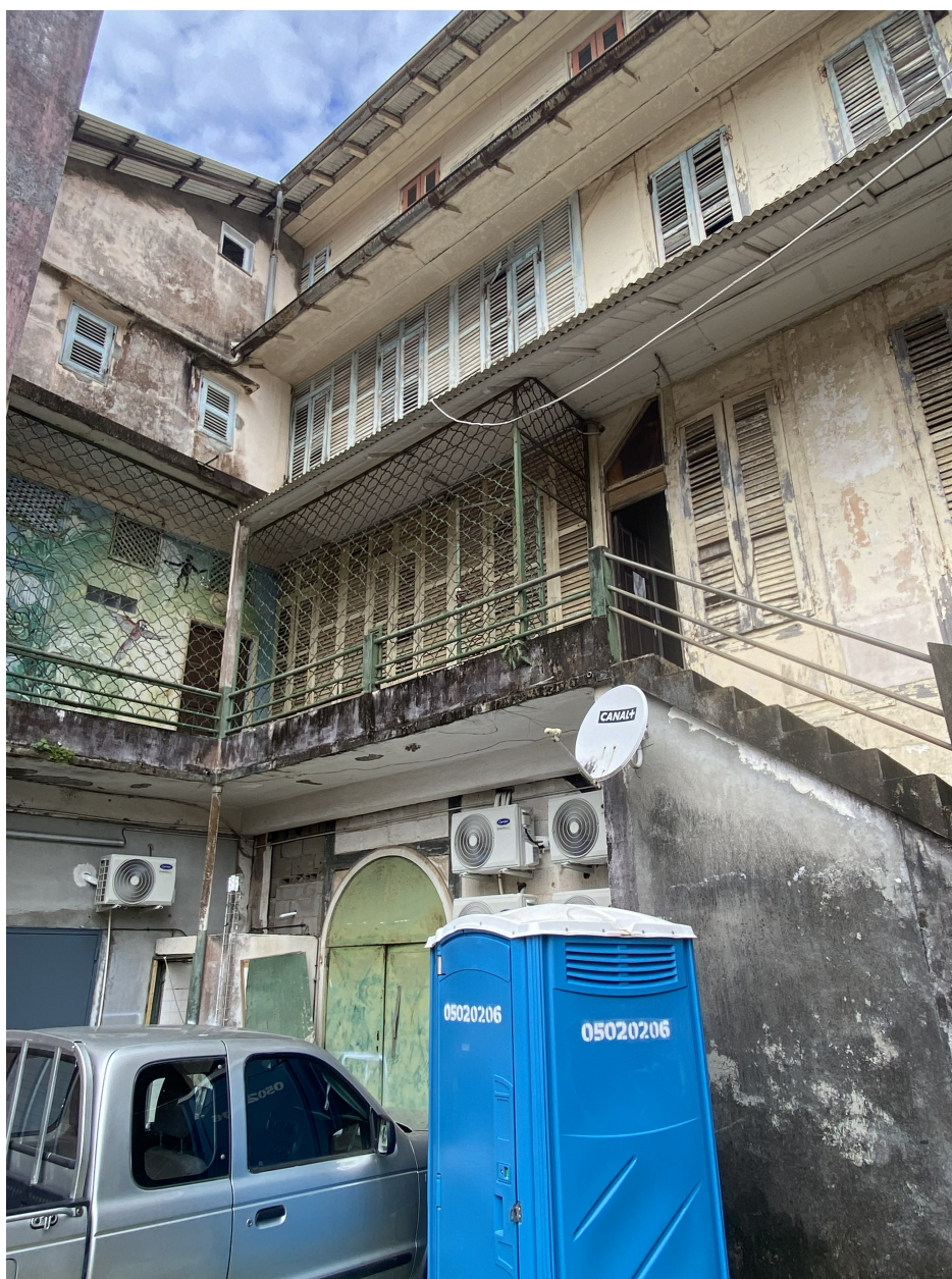
Vue de la façade arrière, état en juin 2026
