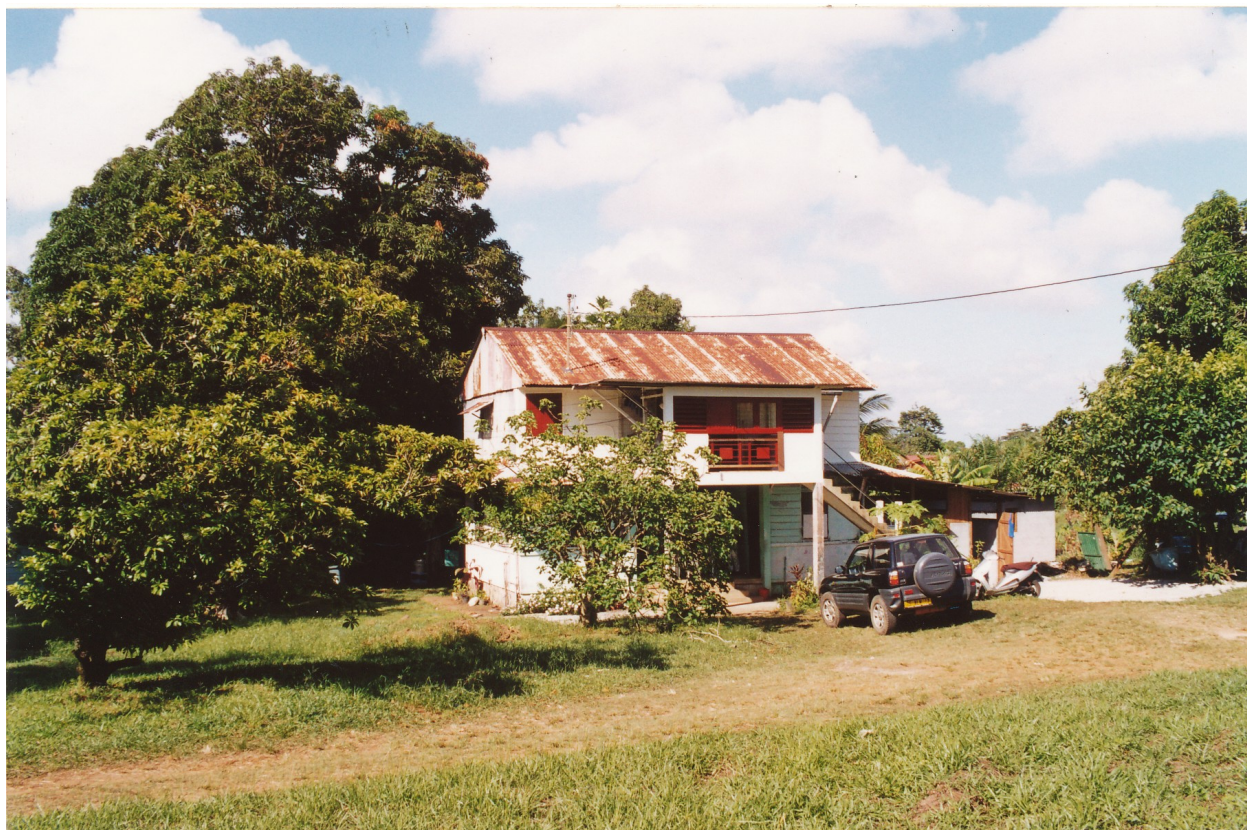
La maison des employés : façade nord, état en 2002
