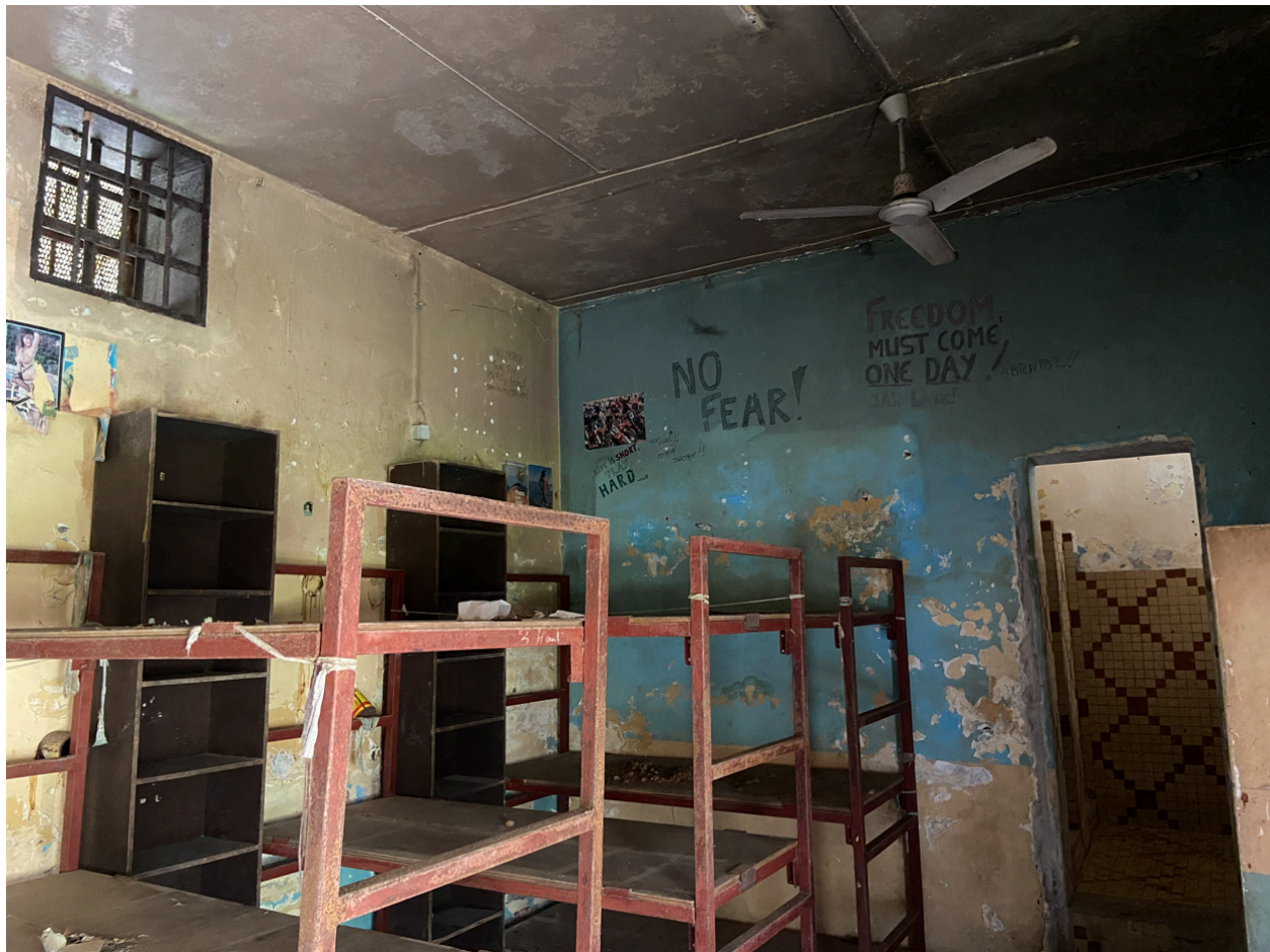
Dortoir des prévenus avec espace salle de bains, état en mai 2026.
