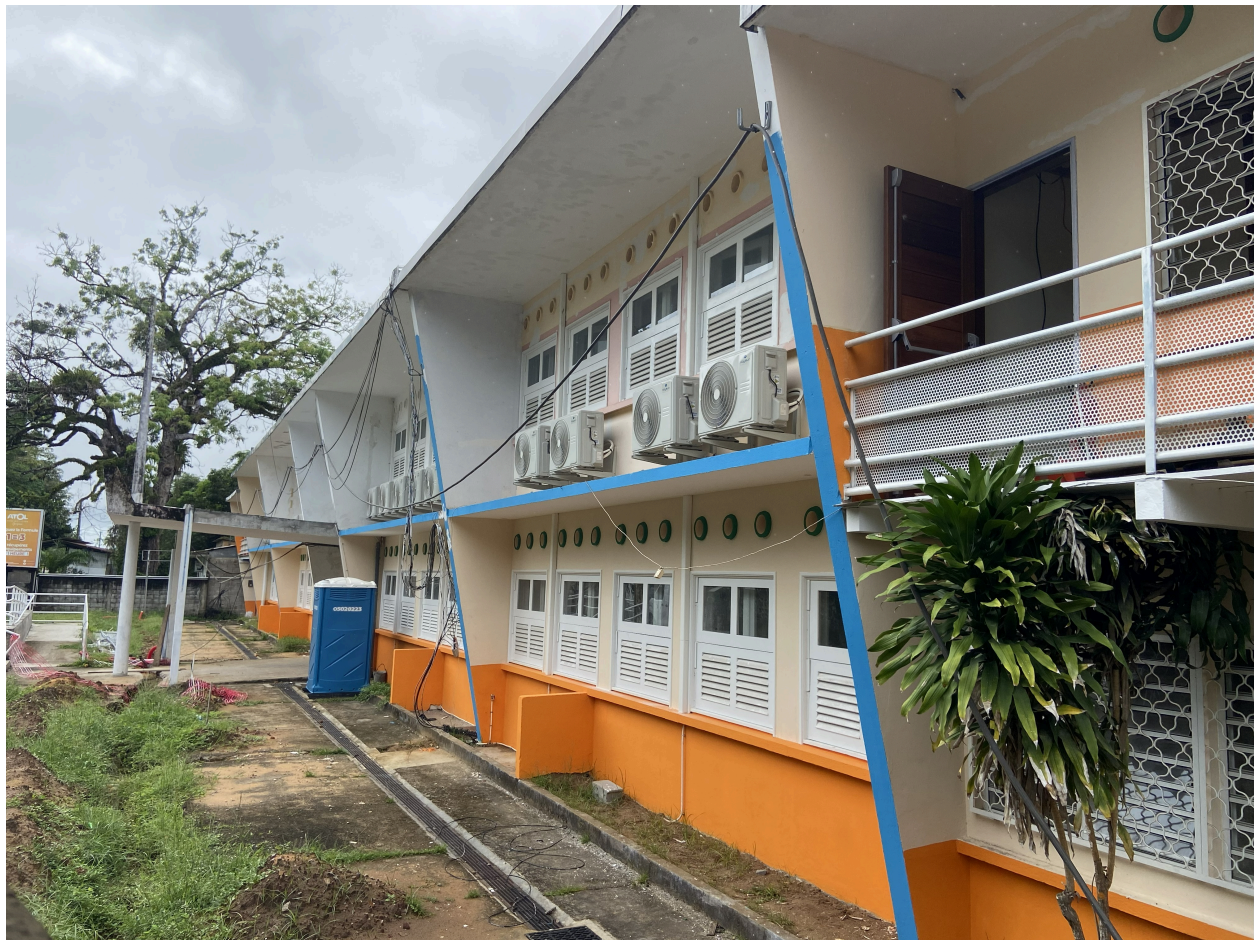
La façade en cours de travaux, mai 2026
