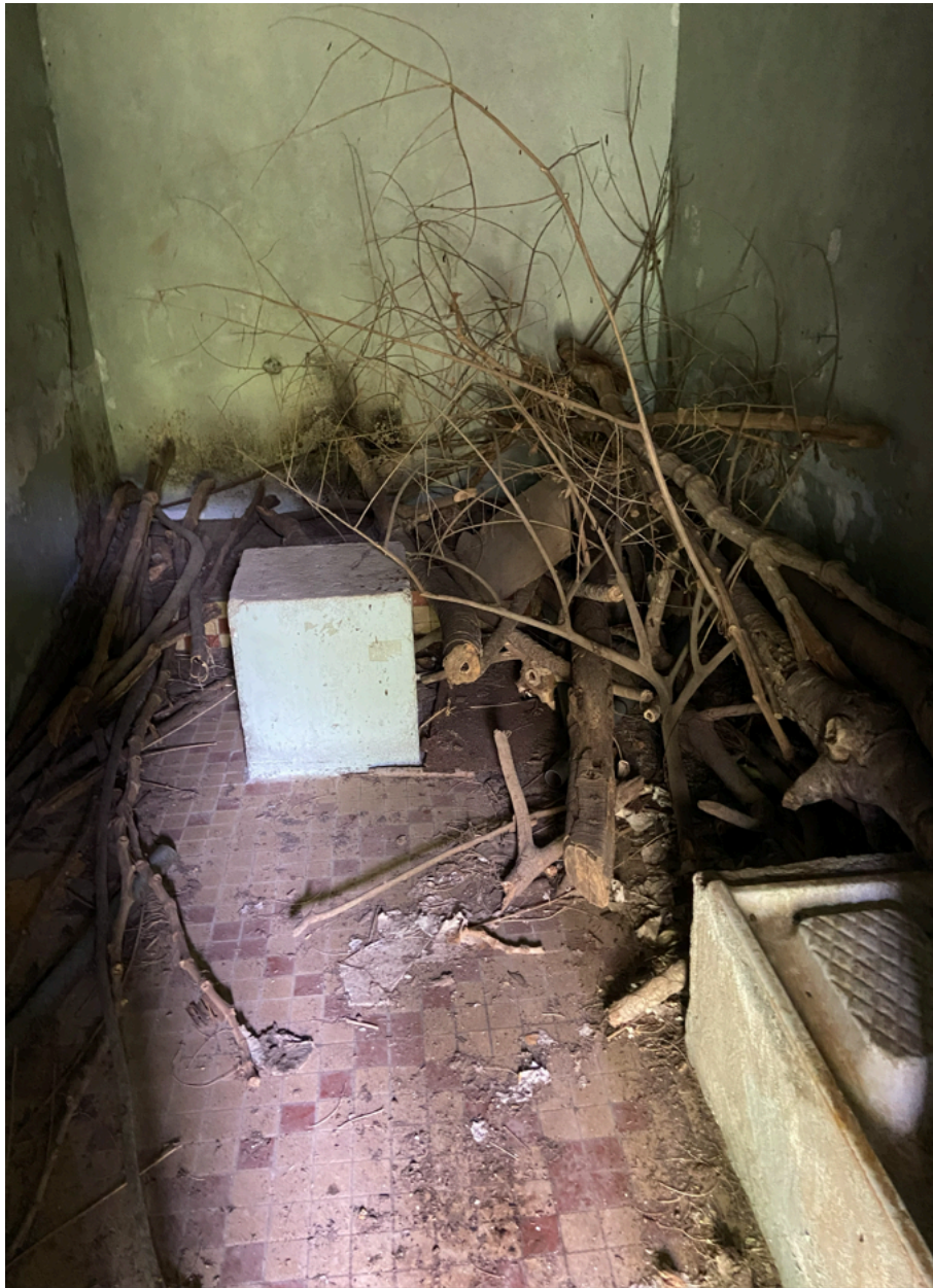
Quartier disciplinaire, détail de l'une des cellules, état en mai 2026.
